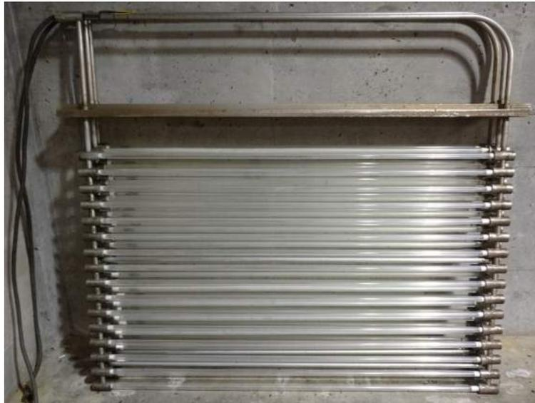
**Figure 27** – Photo d'un ensemble de 50 lampes UV-C basse pression en Hg provenant de la station d'épuration des eaux usées de Québec (baie de Beauport). Caractéristiques : longueur d'un tube UV-C  $\approx 1,55$  m ; prix d'un tube  $\approx 20\$$  ; durée de vie de 1 an ; utilisation 4 mois par an (été) ; période totale d'utilisation 3 ans. Nombre total de lampes dans la station = 4640.  $I_0 = 1,7$  mW/cm<sup>2</sup>. Source : Service du traitement des eaux de la ville de Québec
