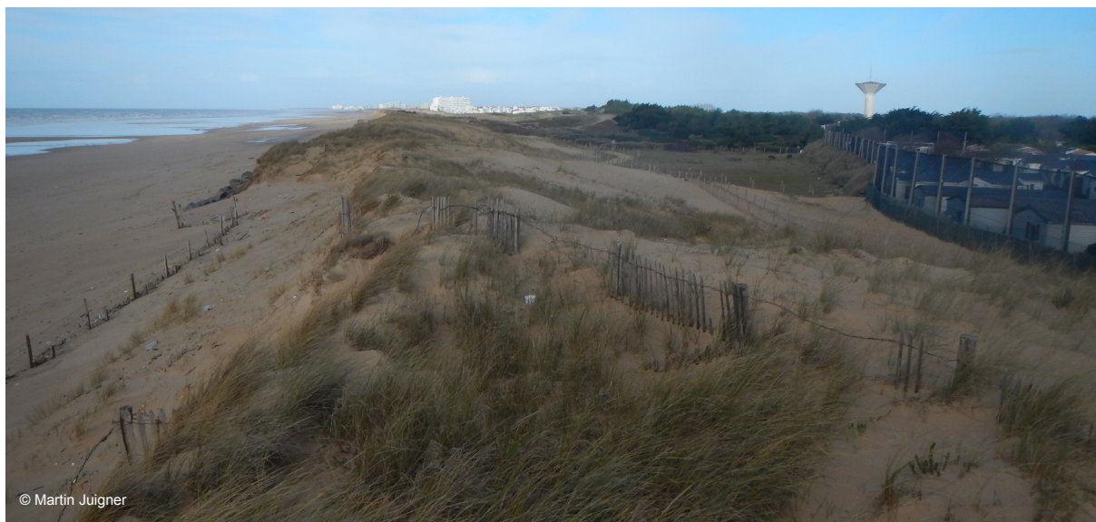
Figure 5 : Exemple de cordon dunaire jouant un rôle de protection face à la submersion marine. Une partie du camping (à droite) est située sous la cote de l'aléa de référence (02 février 2014, La Pègue, Saint-Hilaire-de-Riez, Vendée).
