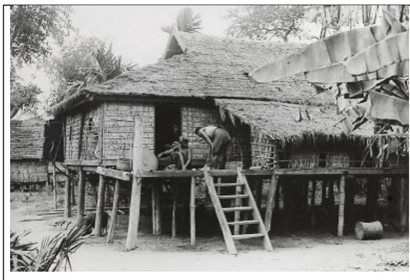
**Fig. 16 :** Le modèle préconisé: la maison *kaintain* à deux toits et trois compartiments. (se référer à la fig. 13).
