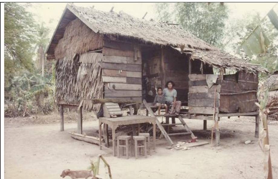
**Fig. 10** : Façade Nord côté « Petite maison ». La cuisine se trouve à l'Ouest sous un appentis (à droite de l'image). Une extension dans la « grande maison » à l'Est permet d'étendre le couchage des nombreux enfants la nuit (les uns à côté des autres, tête dirigée au Nord). Le bois est neuf mais n'a pas été coupé aux dimensions de la maison (gardé pour un éventuel réemploi ou pour le vendre si besoin est). (Photo F. Luco 1995)
