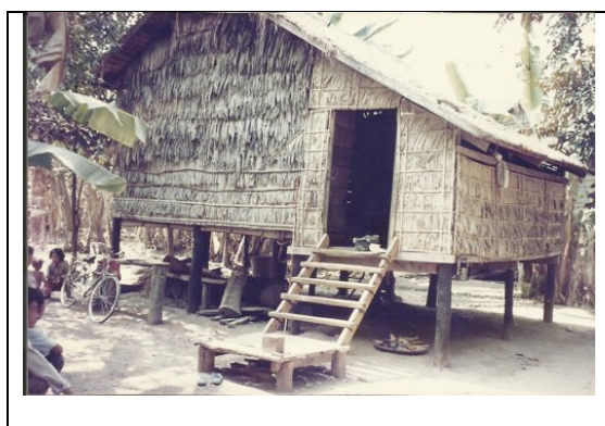
Fig. 29 : Vue extérieure - le plancher de la « petite maison » au Nord (partie à droite de la photo) est plus bas que celui de la « grande maison » au Sud.
