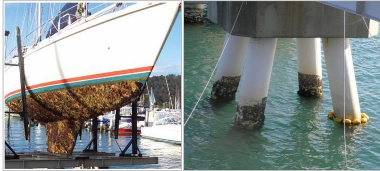
Figure 11 : Photographies de salissures sur une coque de bateau ( www.agriculture.gov.au ) et sur des structures portuaires ( www.eco-guard-systems.co.jp )
