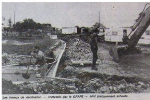
Les travaux de viabilisation - contestés par le GIRAPE - sont pratiquement achevés.
