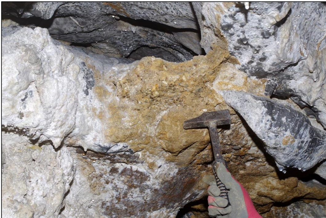
Photographie du point de prélèvement d'ASAR117_001 (porte d'entrée de la galerie Vidal). Photo P. Sorriaux.
