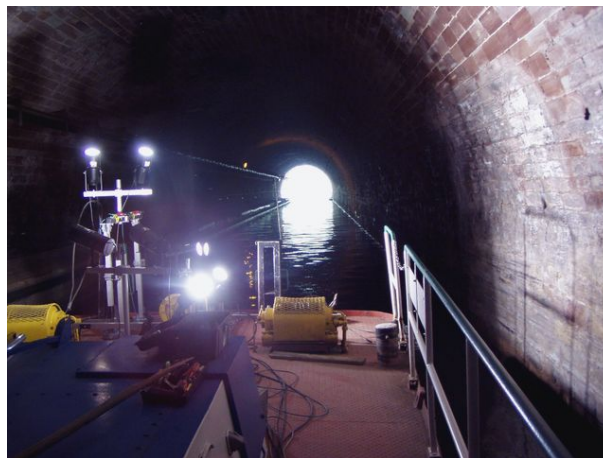
FIGURE 1.9 – Prototype d'acquisition d'images dans le tunnel-canal de Niderviller.
