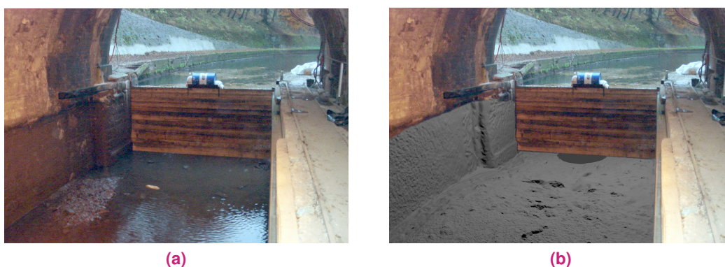
FIGURE 4.24 – Photographie (source : archive VNF) de l'entrée nord du tunnel après la vidange de celui-ci pour maintenance en 2009 (a) et la représentation 3D maillée de cette zone à partir des données sonar (b). Le modèle 3D est aligné approximativement sur la photographie.
