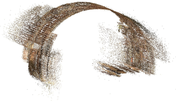
FIGURE 3.19 – Illustration d'un sous-modèle calculé sous Photoscan correspondant à un profil de tunnel de 2 m.
