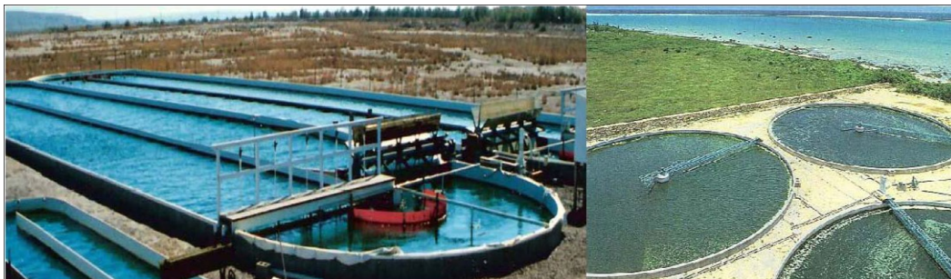
Figure I-10 : Bassins de culture de micro-algues. A gauche : bassin en boucle fermée, infrastructure de Roswell, Nouveau Mexique (USA) (Weissman et al., 1988). A droite : bassins circulaires d'environ 500 m 2 , production de chlorelle (Chlorella Industries, Japon) (Lundquist et al., 2010)
