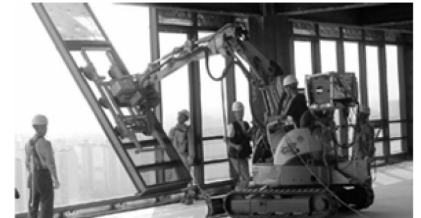
(c) Robot mobile utilisé pour poser des baies vitrées LEE 2010
