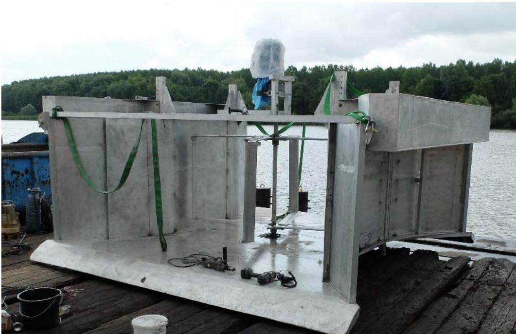
FIGURE 4.14 – Photographie du prototype d'hydrolienne BEC lors de son installation dans l'Escaut.
