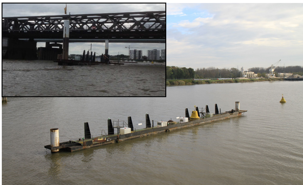
FIGURE 4.10 – Ponton flottant acheminé vers le site de test à proximité du pont de Temse.
