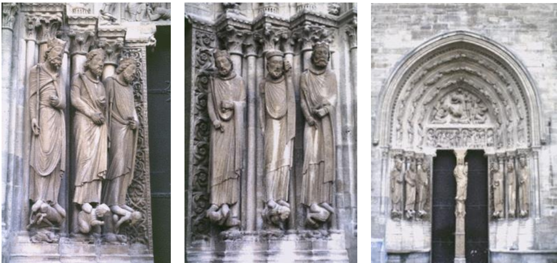
Figure 136 : Portail des Valois après restauration par Groux (1998) ©LRMH ; noter les contrastes de couleur entre les parties hautes et basses du portail (photos argentiques).
