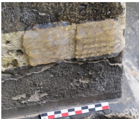
Figure 18 : Application de compresses de gel d'agar pour réduire la coloration jaune à la cathédrale de Chartres (source: De Oliveira, 2014a).
