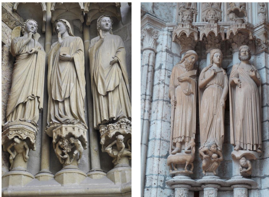
Figure 11 : Contrastes de couleur dus à l'emploi de différentes techniques de nettoyage ; gauche : portail de la Mère-Dieu, cathédrale d'Amiens en 2017 ©LRMH ; droite : portail du transept nord, cathédrale de Chartres en 2012 ©Rolland.
