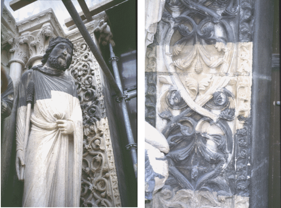
Figure 135 : Essais de nettoyage laser par Jean Delivré (1993) ©LRMH.
