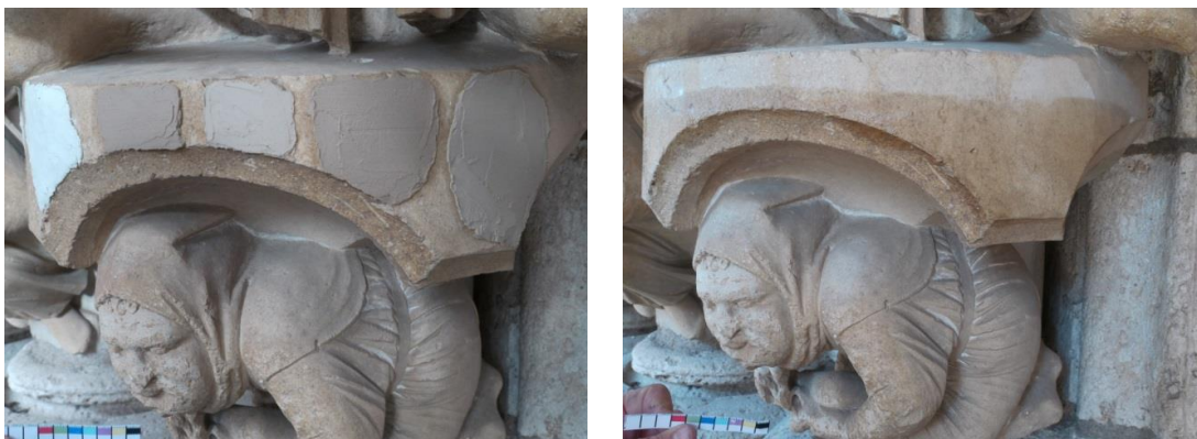
Figure 17 : Tests de différentes compresses à Chartres, avant et après application ; (source : Rolland, 2012).
