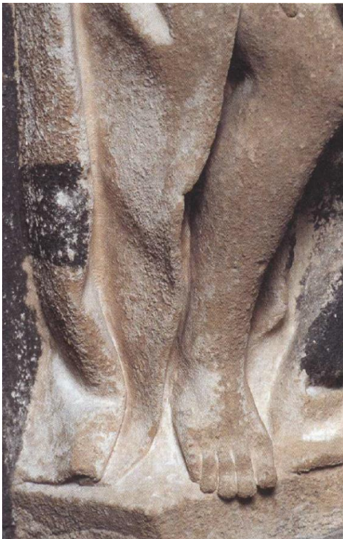
Figure 12 : Zone nettoyée au laser de l'église Saint-Michel de Bordeaux ; la patine et les fragiles écailles visibles sur l'épiderme de la pierre ont pu être préservées grâce à un nettoyage laser minutieux (source : Bromblet et al , 2003).
