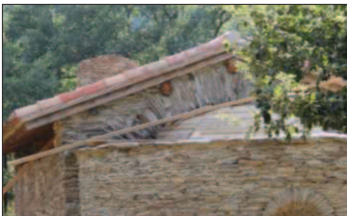
Saint-Julien de Vallventosa (Corbère) : mise en place d'un cintre et de son couchis réalisé en petites planches, afin de reconstruire la voûte en cul-de-four de l'abside
