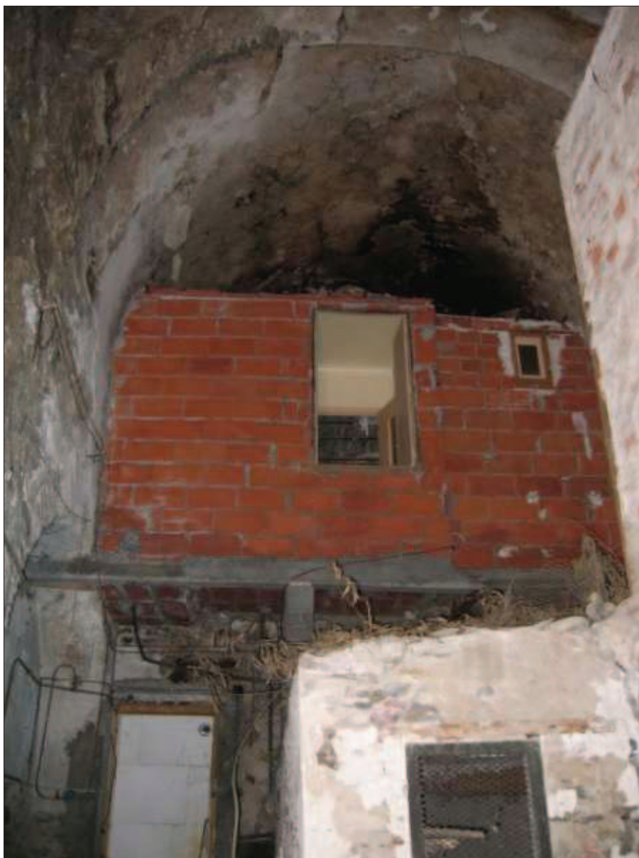
Vue des vestiges d'une partie de la nef d'est en ouest
