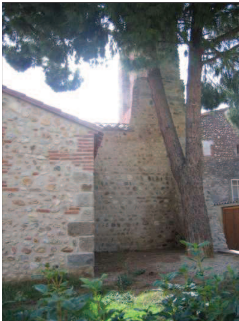
Partie ouest de la façade septentrionale
