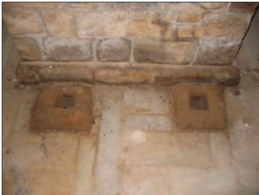
Autel surélevé (haut gauche), cathèdre maçonnée (haut droit) Pierres monolithes avec orifice positionnées derrière l'autel (bas)
