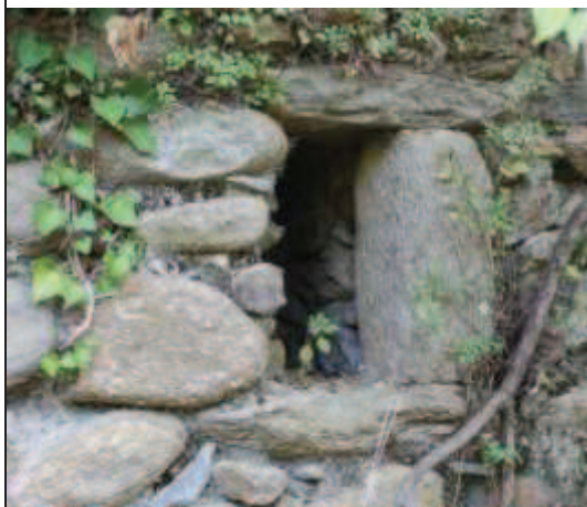
Baie est du chevet (sise au nord)
