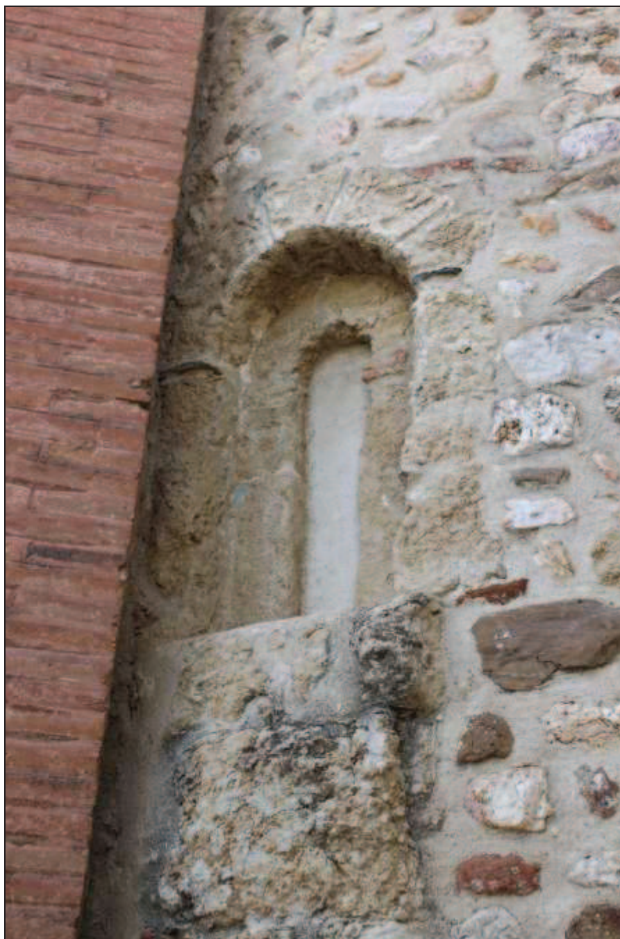
Baie axiale en travertin du chevet primitif
