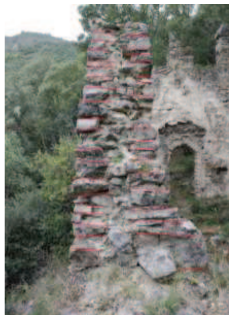
III.9 et 10, Murs avec parements de moellons maçonnés en boutisses (en rouge) et fourrure. Mur septentrional de Saint-Laurent de Torrent (Laroque-des-Albères) à gauche, et de Sainte-Agnès de Croanques (Taulis) à droite.
