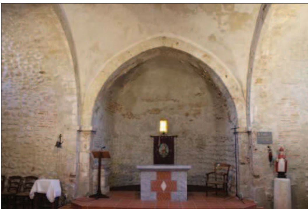
Nef d'ouest en est (haut), abside (bas)
