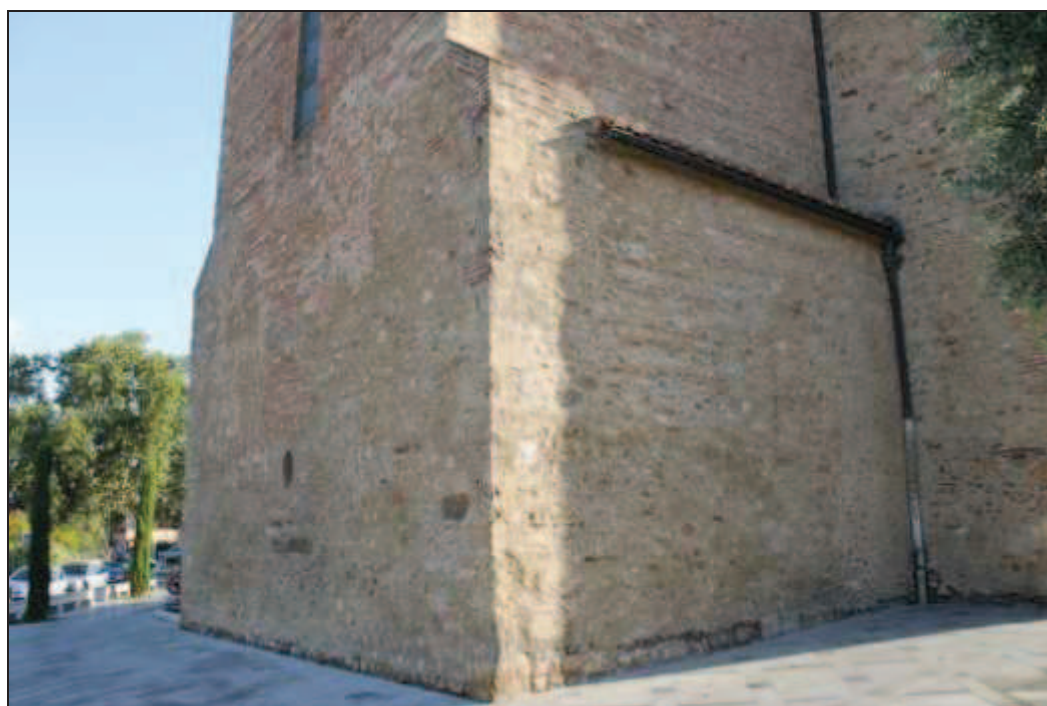
Façade méridionale (haut), angle sud-ouest (bas)
