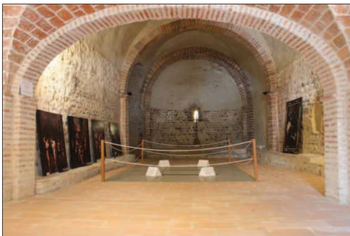
Façade méridionale (haut), nef vue d'ouest en est (bas)
