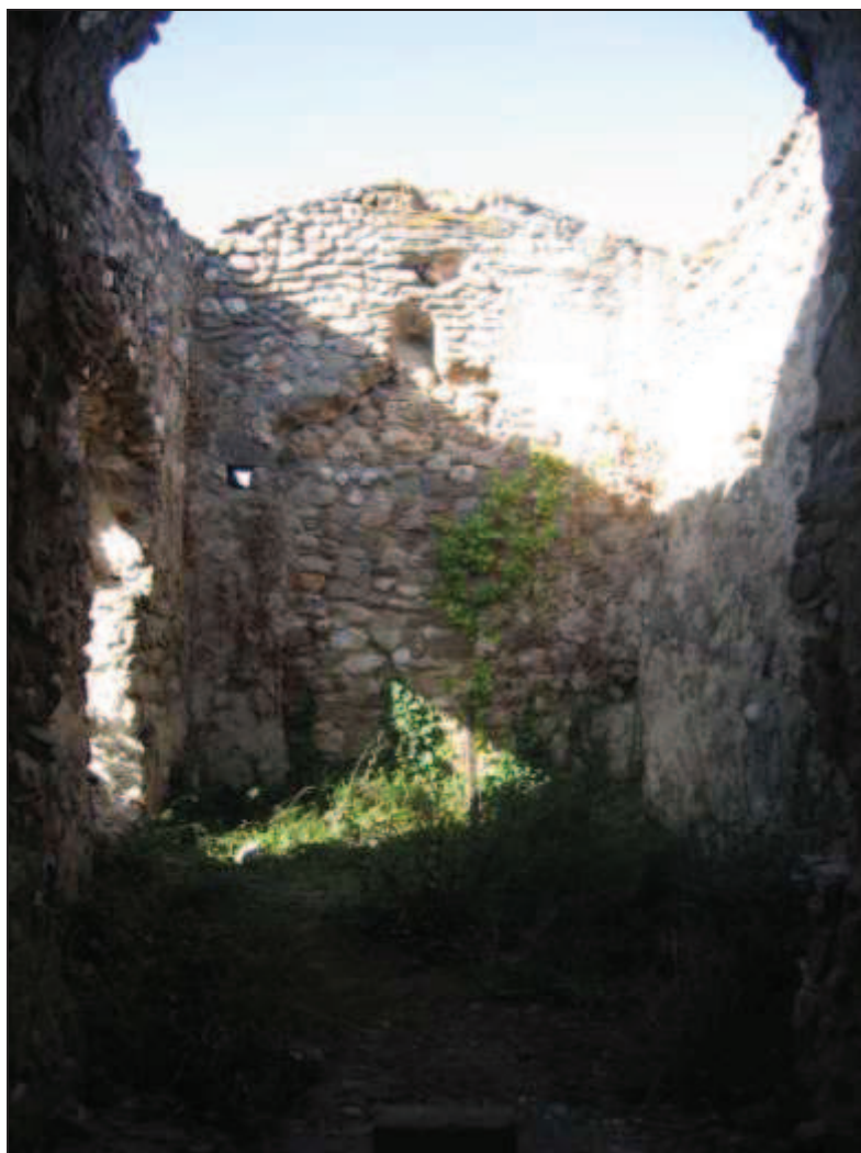
Nef, vue depuis l'est
