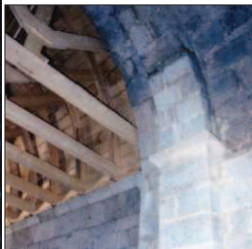
Saint-Martin de Corsavy : restauration de la voûte en 2003, le cintrage s'appuie sur la corniche romane
