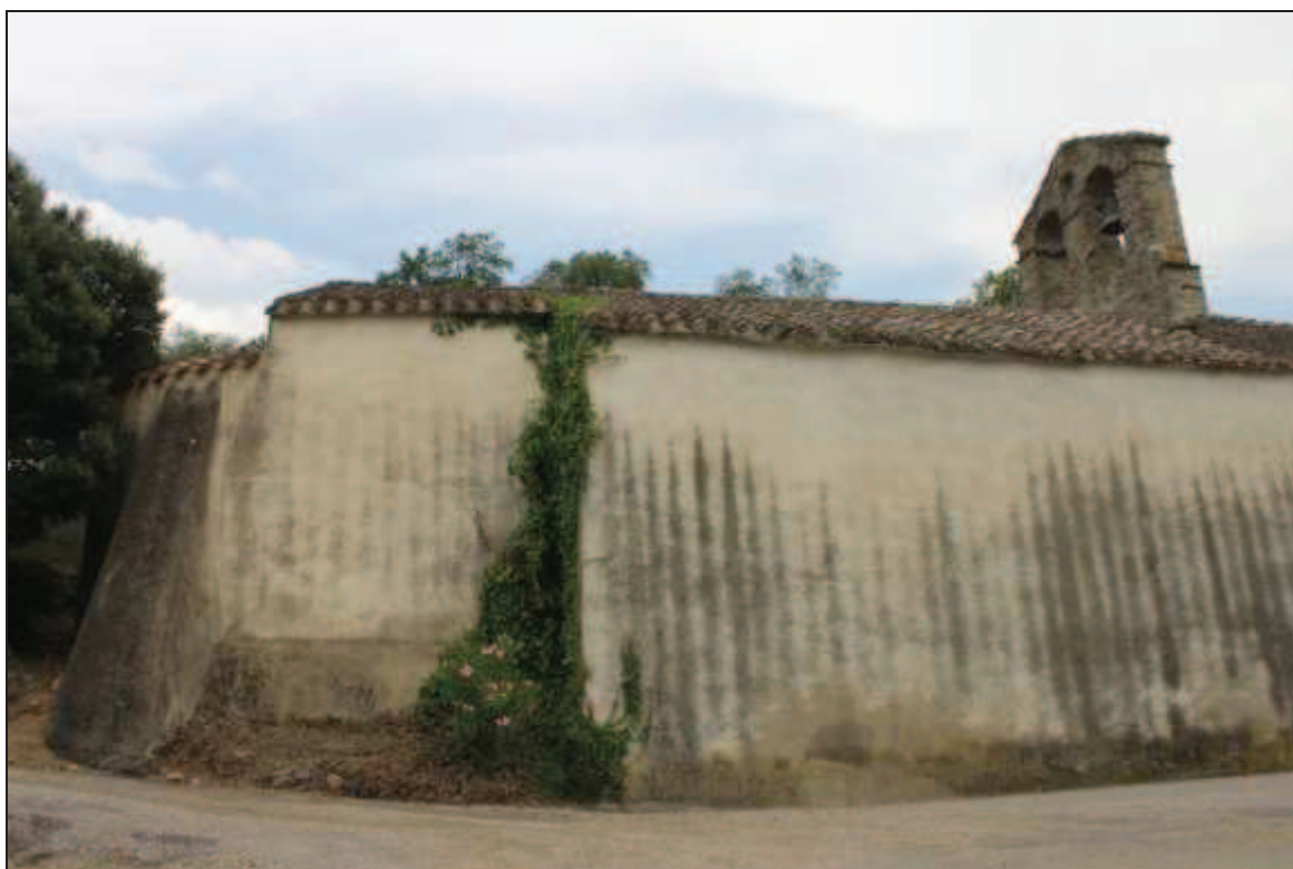
Murs gouttereaux : méridional (haut), et septentrional (bas)
