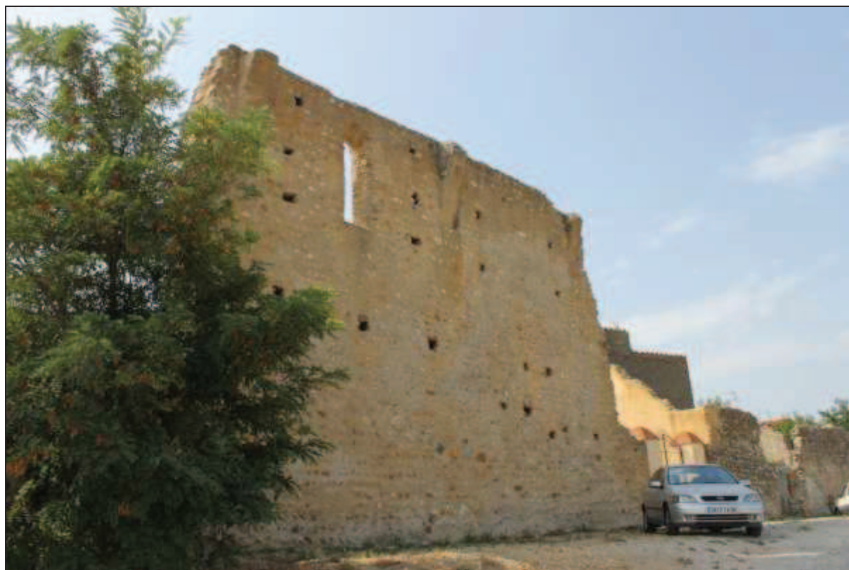
Vestiges du mur gouttereau méridional, partie intérieure
