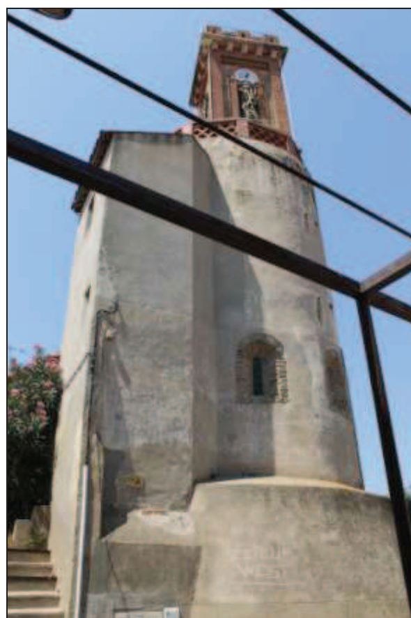
Façade méridionale (haut), chevet fortifié (bas)
