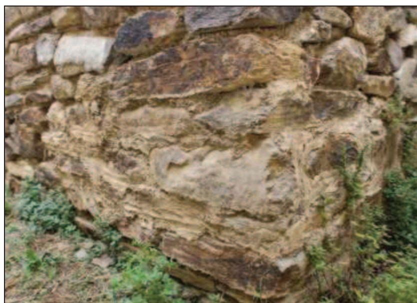
Vestiges du clocher-tour (haut) et joints dits « à la pointe de la truelle », angle sud-est du clocher (bas)
