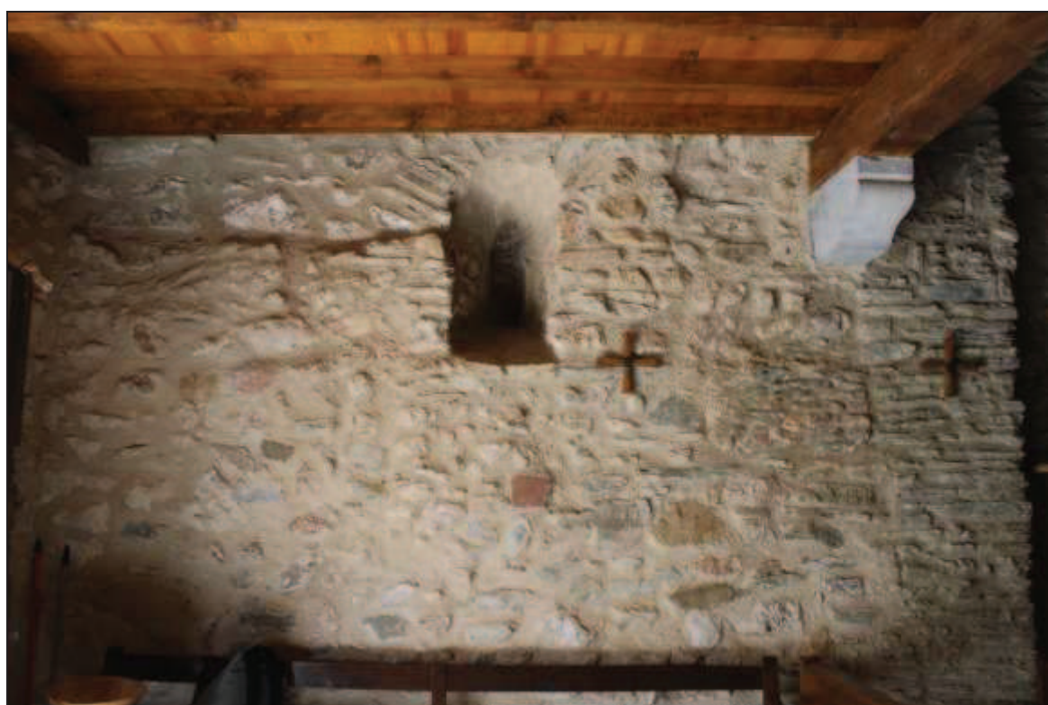
Mur gouttereau méridional (haut), ancienne baie sud du chevet (bas)
