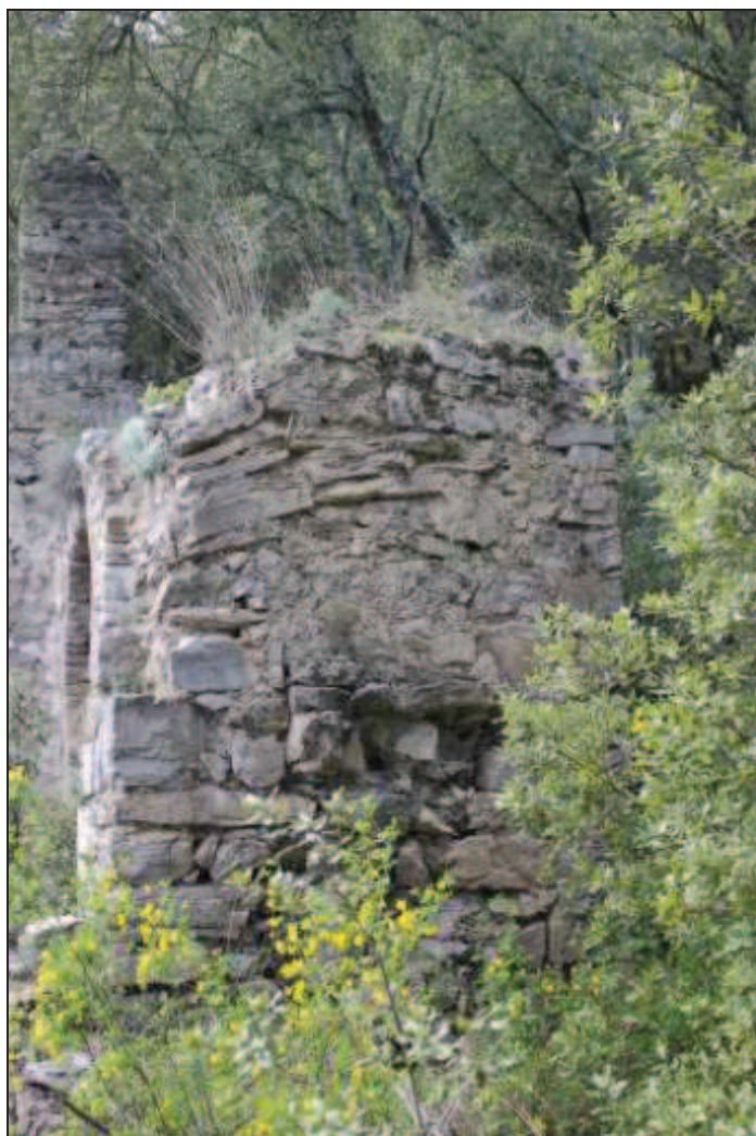
Vestiges du départ nord de l'arc triomphal, vu depuis l'est
