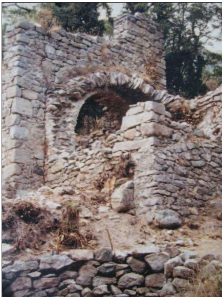
Chevet avant restauration
