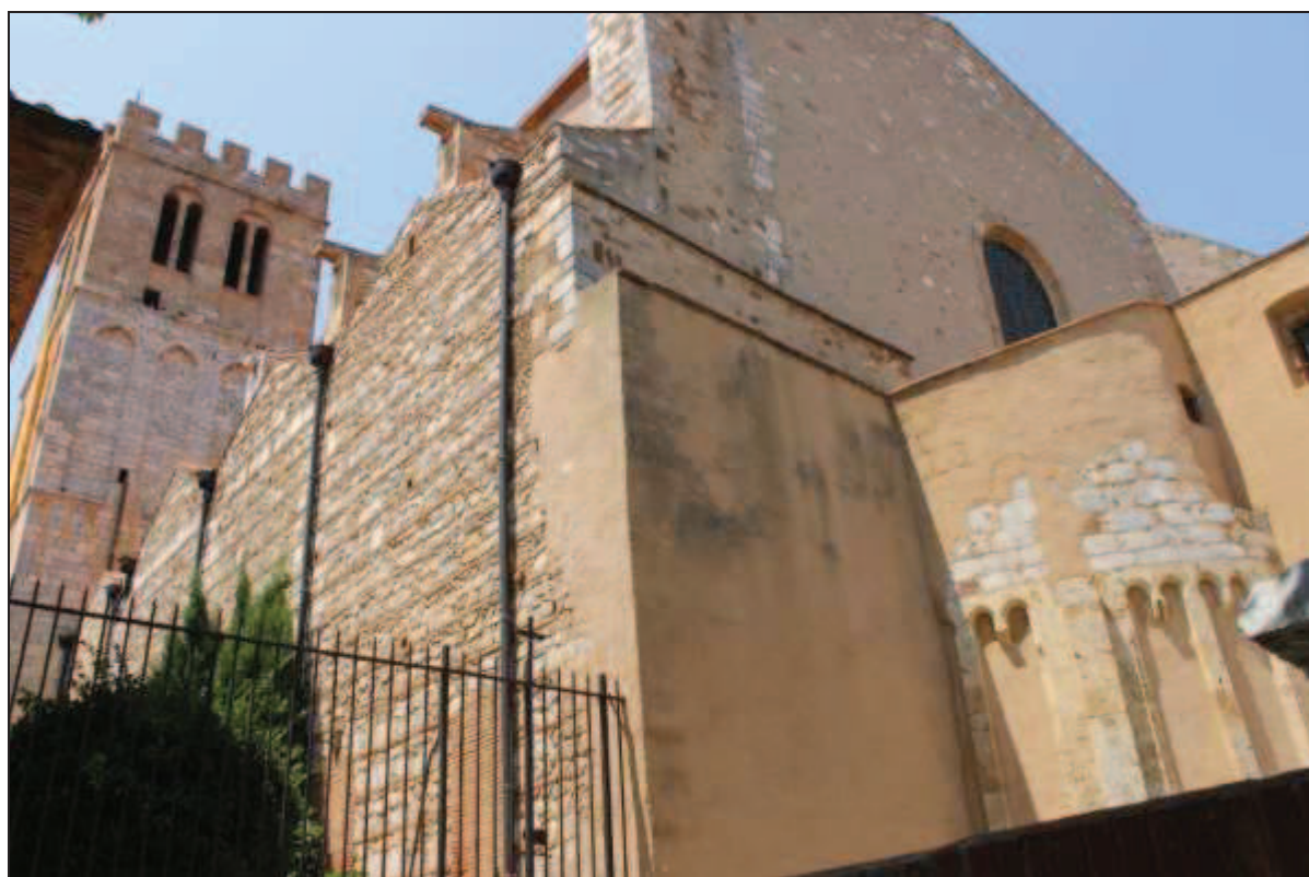
Façade orientale (haut) et façade méridionale (bas)
