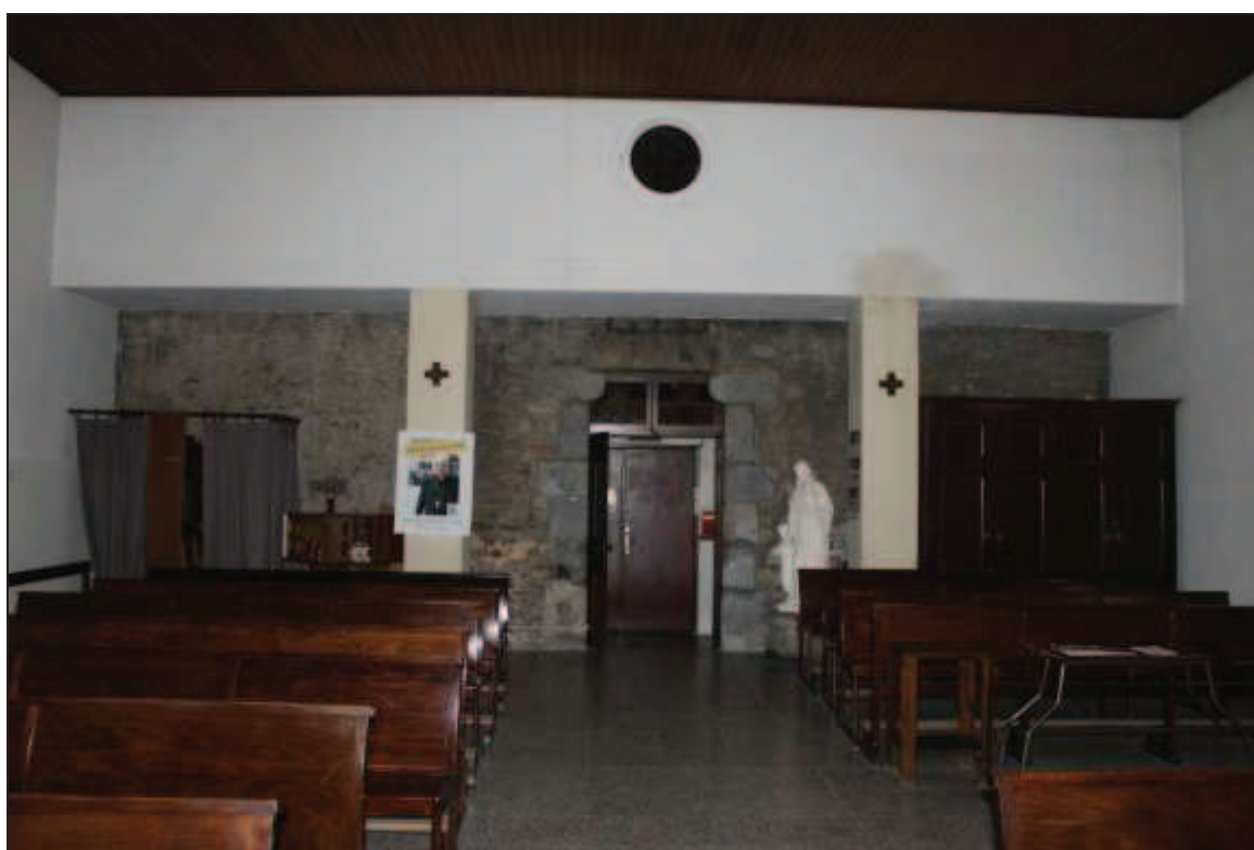
Mur gouttereau septentrional (haut) ancienne entrée méridionale (bas)
