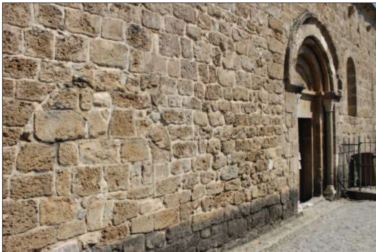
Ancien portail d'entrée à droite et son confrère roman à gauche
