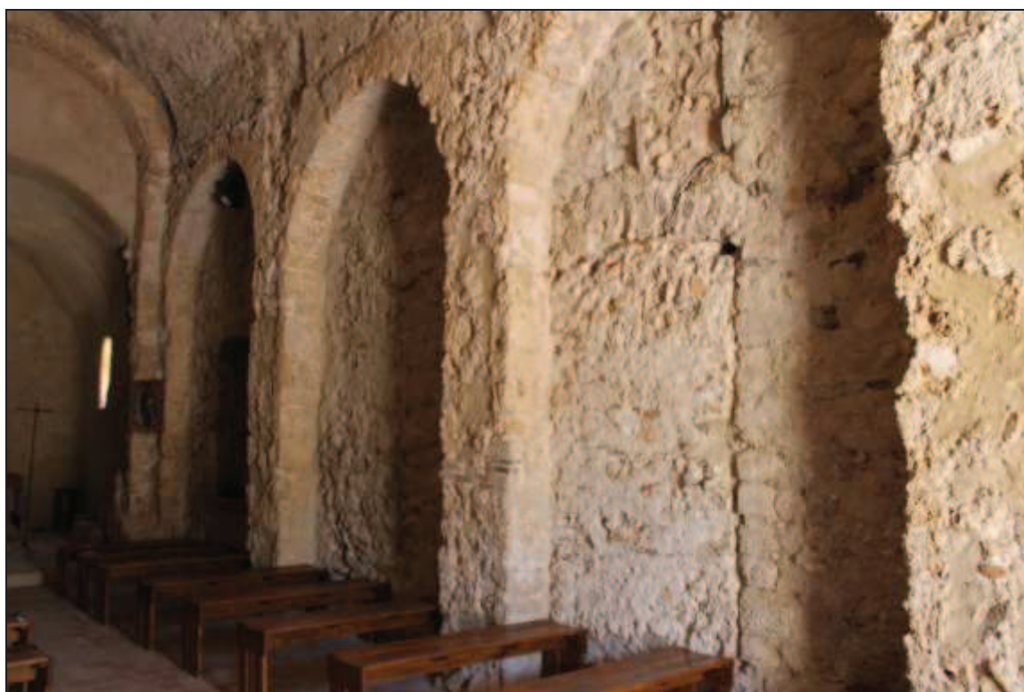
Mur gouttereau nord (haut), mur gouttereau sud (bas)
