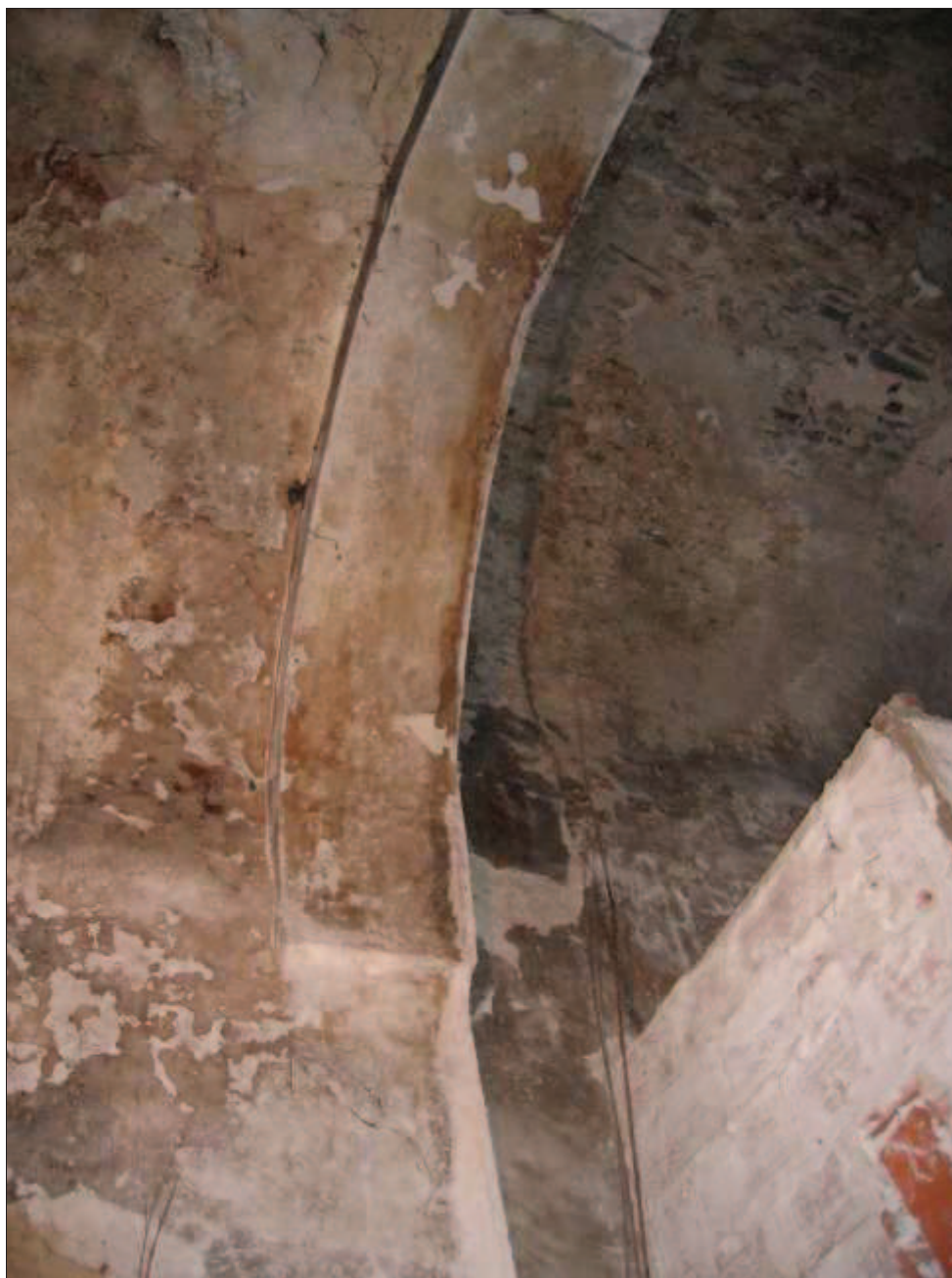
Départ du doubleau depuis le mur nord de la nef
