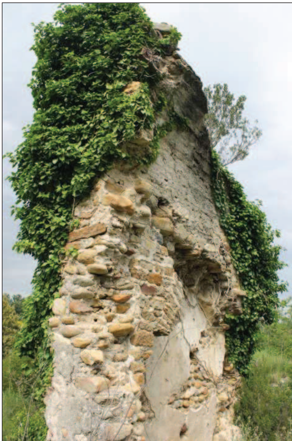
Vestiges du mur gouttereau nord, vus depuis l'occident
