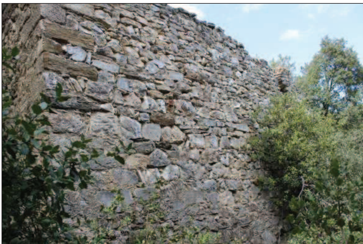
Mur nord (haut), mur sud (bas)
