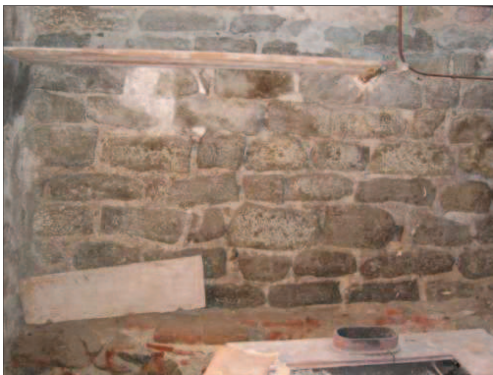
Traces de joints à la pointe de la truelle, mur sud (haut), assises basses du mur gouttereau méridional (bas)
