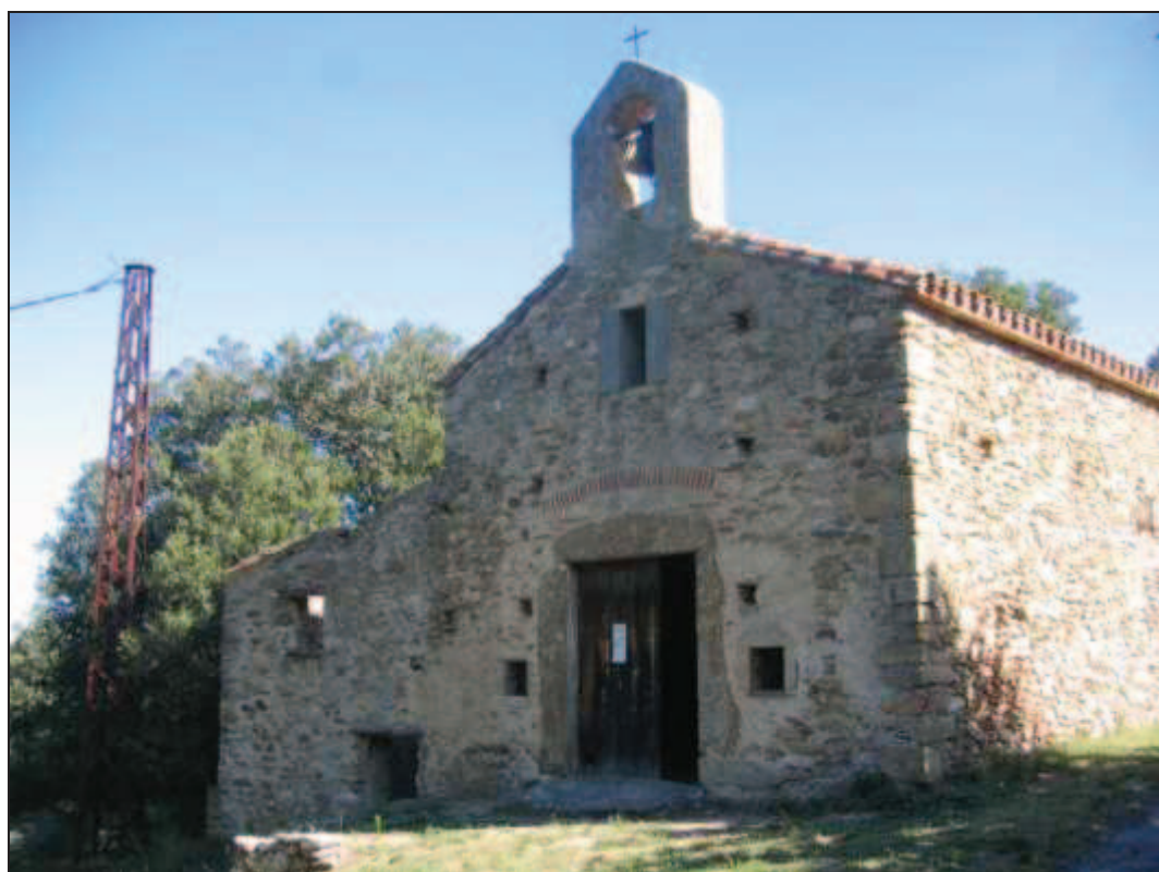
Mur méridional (haut) et Façade occidentale (bas)
