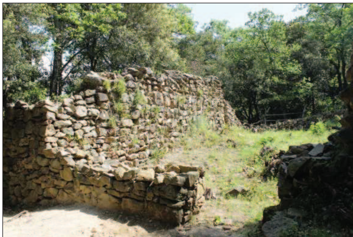
Mur septentrional (haut), et mur nord de la nef (bas)
