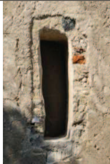
Baie ouest du mur gouttereau méridional
