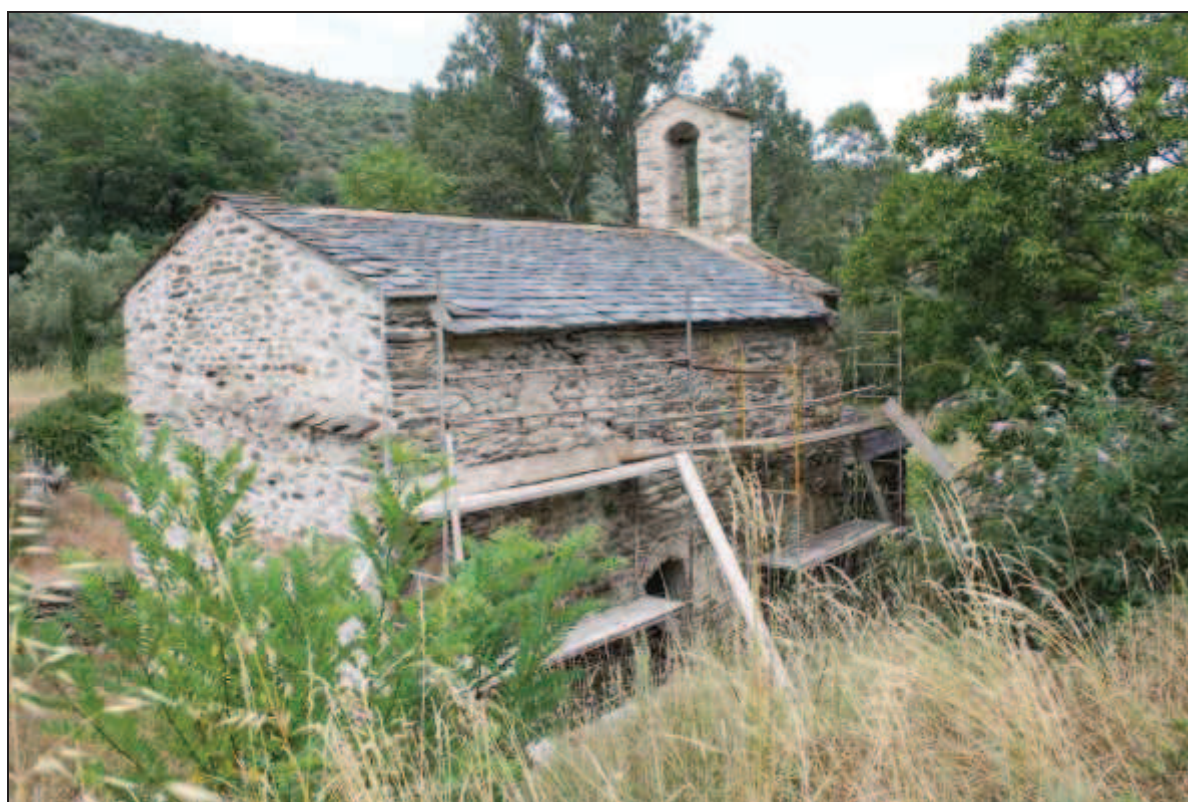
Façade ouest (haut), façade sud (bas)
