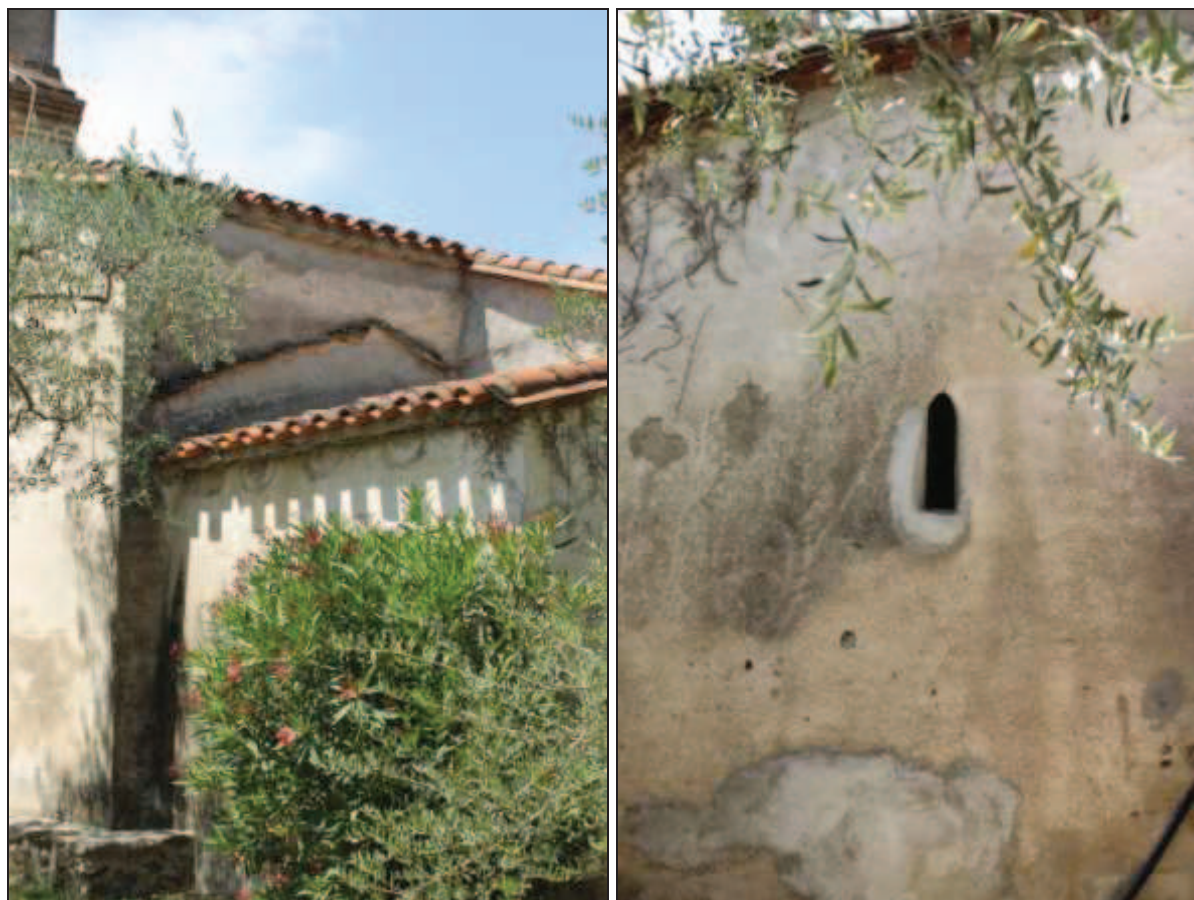
Etat actuel de la partie est (gauche), baie axiale (droite)
