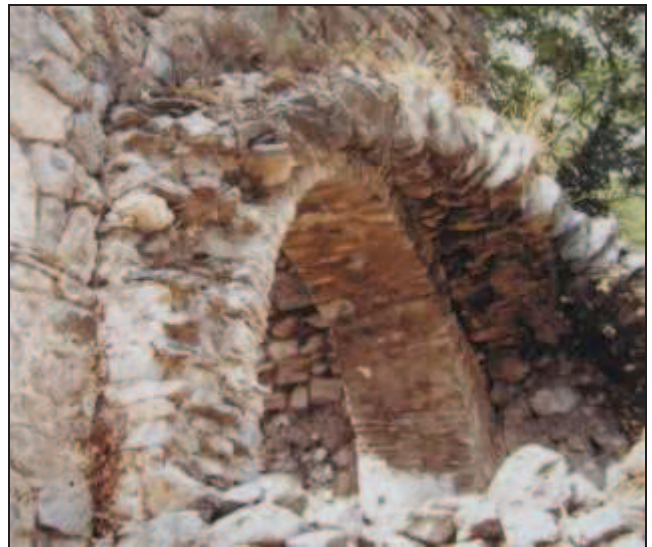
Ill.14 Sainte-Cécile-de-Cos (le Tech) – Vestiges des pierres constituant l’intrados de la voûte plein-cintre de l’abside.
