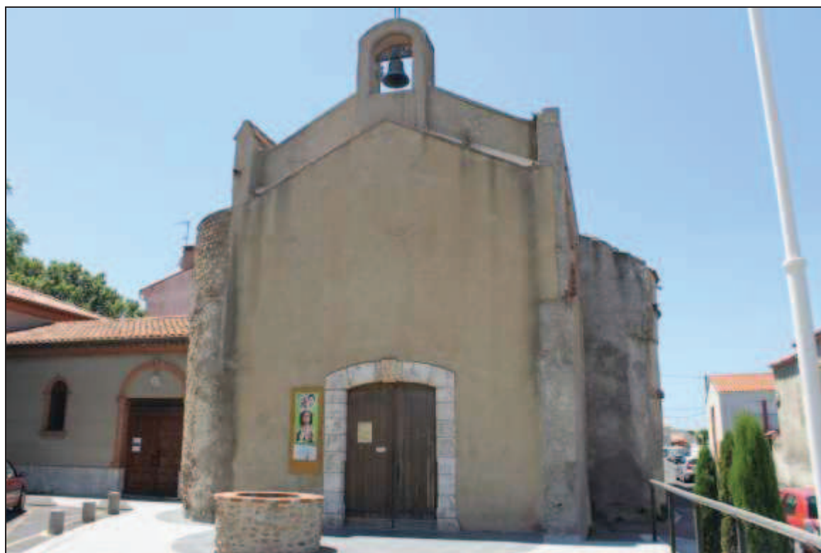
Ancien chevet, vu depuis le sud (haut) et depuis l'est (bas)
