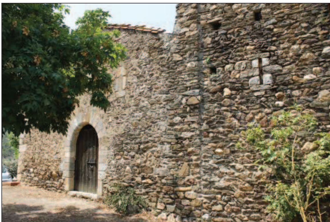
Façade méridionale, depuis l'angle sud-ouest (haut), depuis l'angle sud-est (bas)
