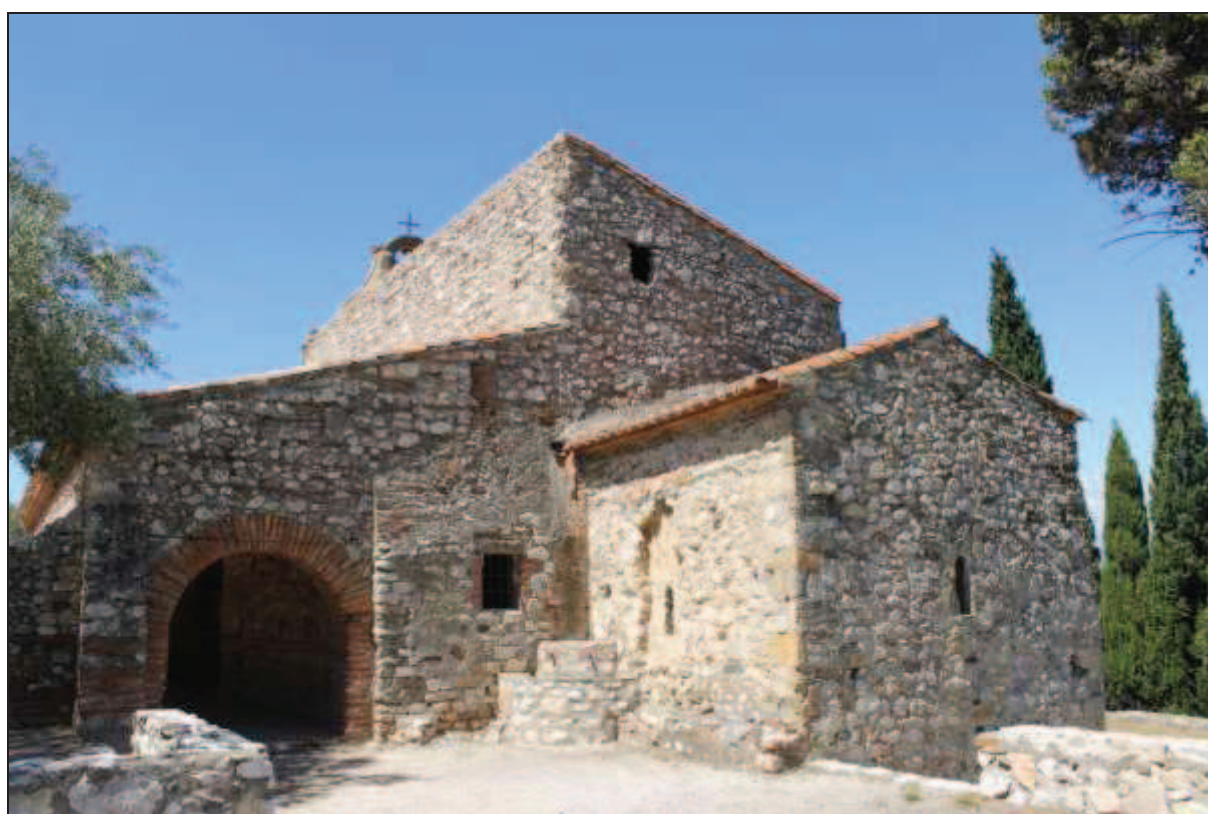
Façades méridionale et occidentale (haut) et face orientale (bas)
