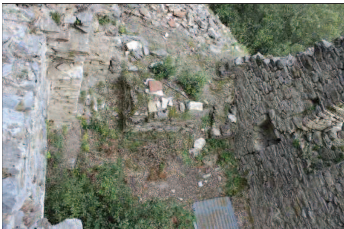
Nef vue d'est en ouest (haut), vue plongeante sur l'est et vestiges de l'abside (bas)
