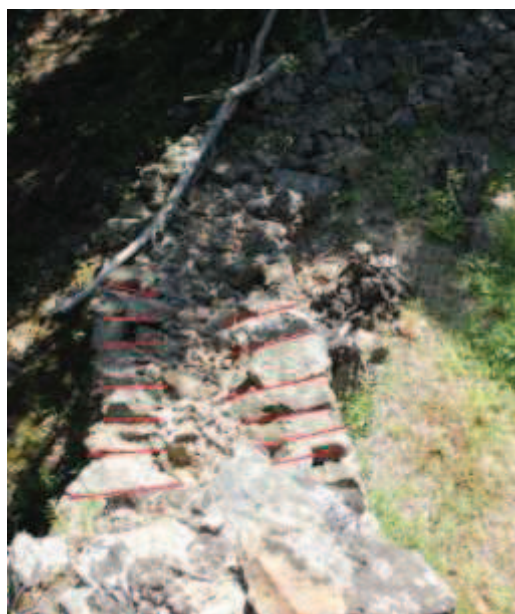
III.9 et 10, Murs avec parements de moellons maçonnés en boutisses (en rouge) et fourrure. Mur septentrional de Saint-Laurent de Torrent (Laroque-des-Albères) à gauche, et de Sainte-Agnès de Croanques (Taulis) à droite.
