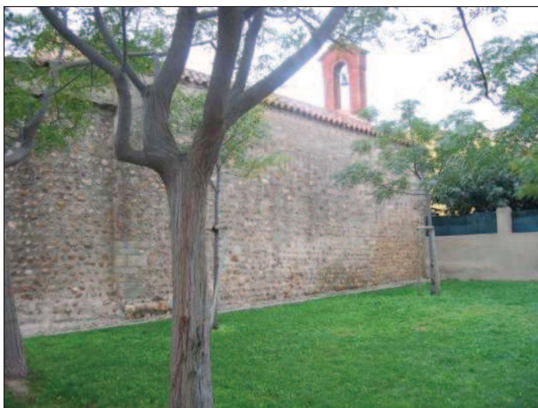
Façade méridionale (haut), mur gouttereau septentrional (bas)
