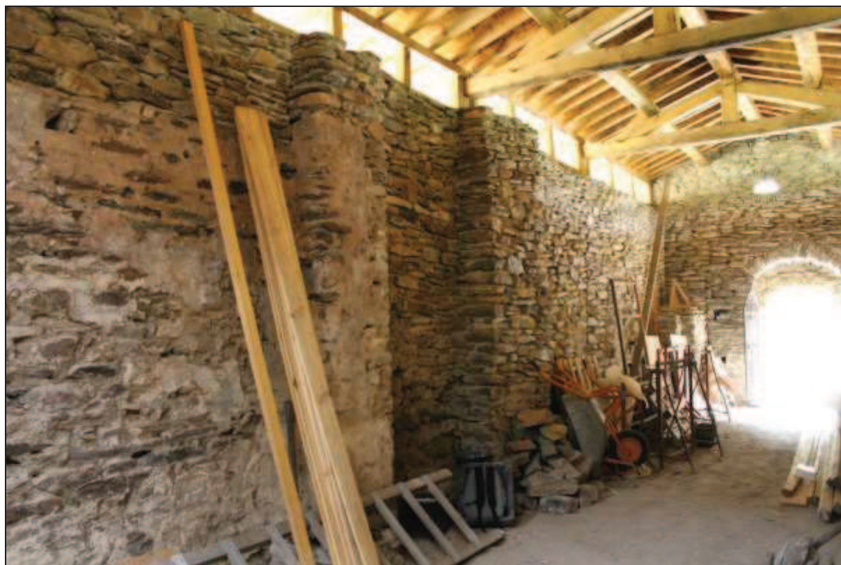
Mur gouttereau méridional, vue depuis l'est
