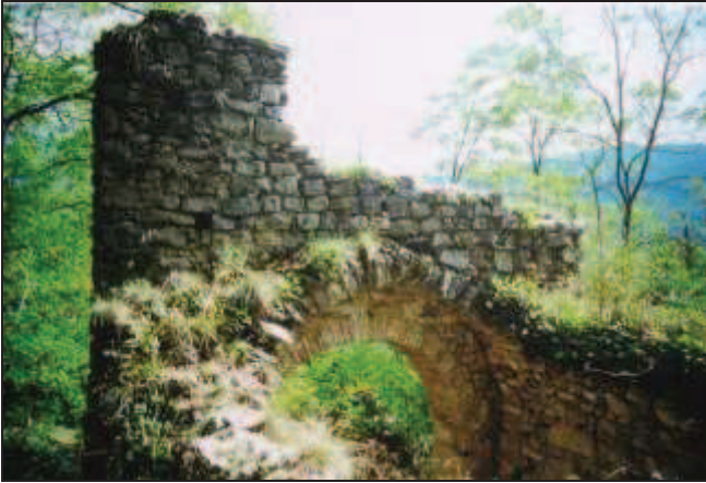
Ill.16. Sainte-Cécile de Cos (le Tech) – Vestiges de l'arc triomphal surmonté du clocher-mur, vus depuis le nord de la nef, en amont de l'abside
