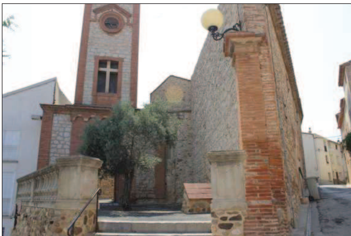
Façade septentrionale (haut), partie est (bas)
