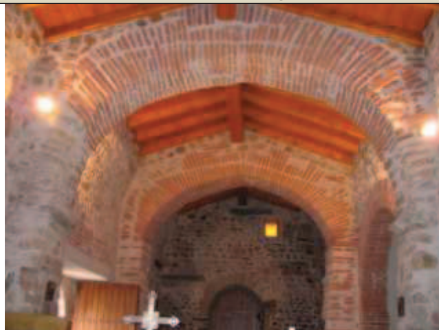
Vestiges de doubleau transformés au XVIII ème siècle en arcs diaphragmes
