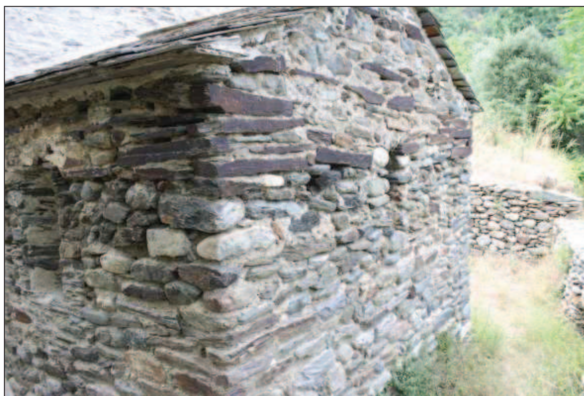
Façade nord (haut), angle sud/est du chevet (bas)
