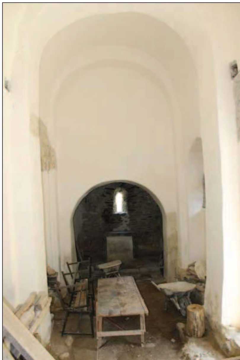
Vue de la nef d'ouest en est
