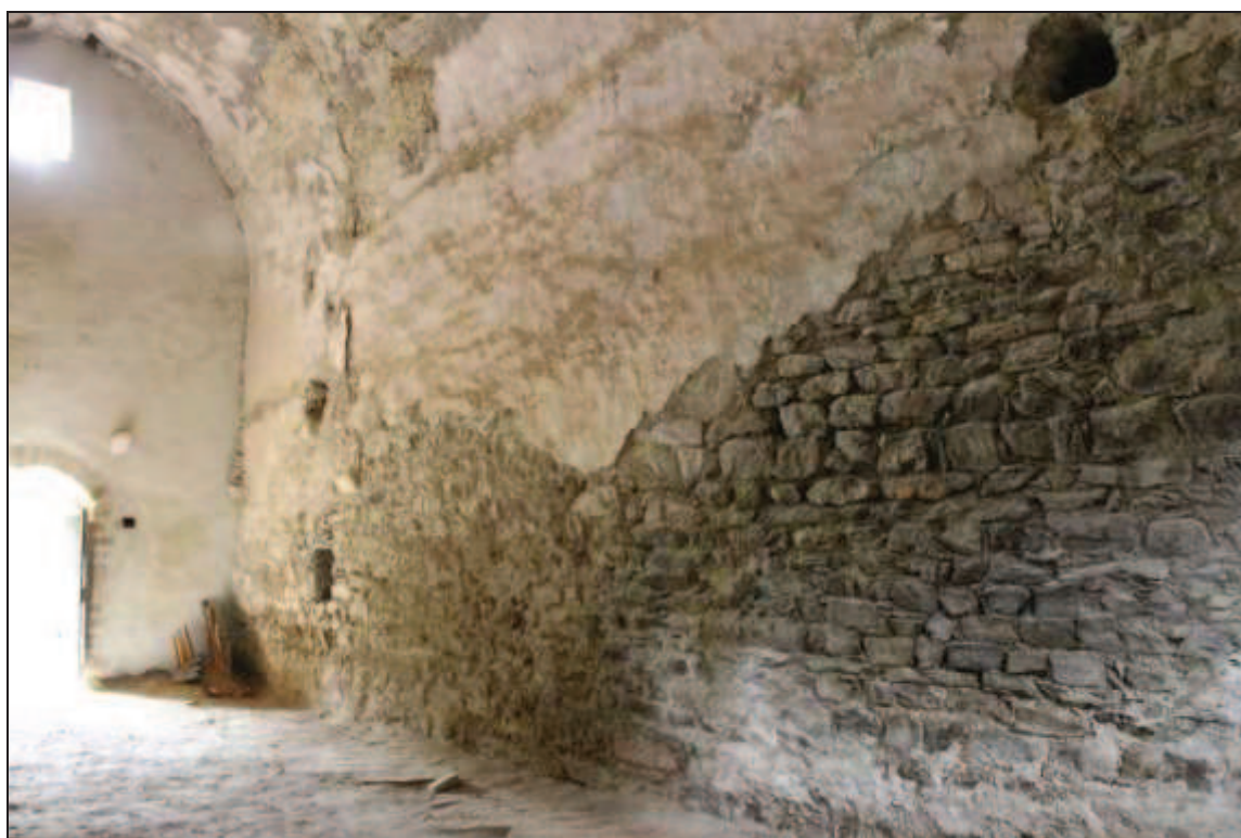
Vue de la nef d'ouest en est (haut), mur nord vu depuis l'est (bas)
