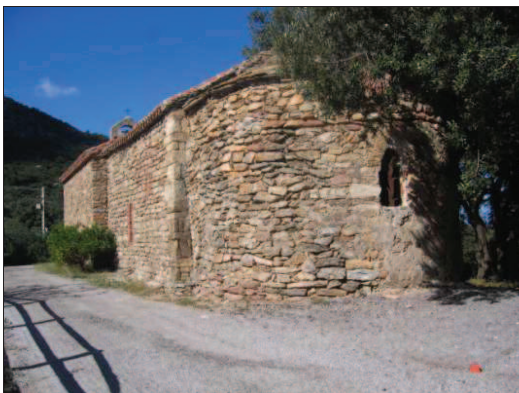
Chevet et mur gouttereau nord
