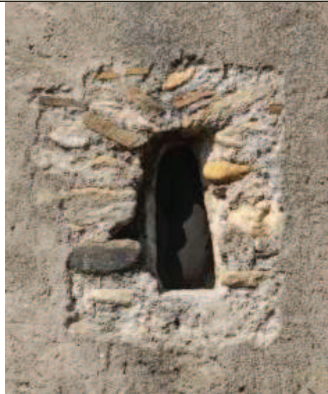
Baie est du mur gouttereau méridional
