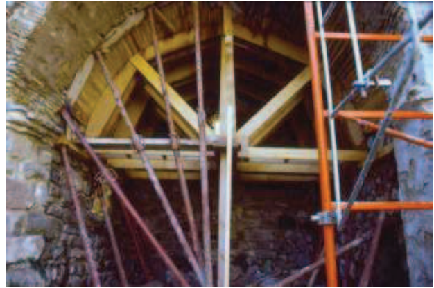
Ill.17. Sainte-Cécile de Cos (le Tech) – Positionnement du coffrage en appui sur l'arc triomphal pour la restauration de la voûte en plein-cintre de l'abside.
