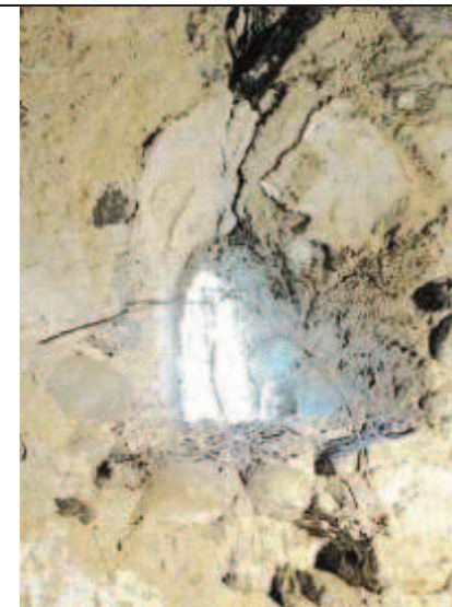
Baie d'axe, intérieur
