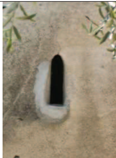
Baie d'axe, extérieur
