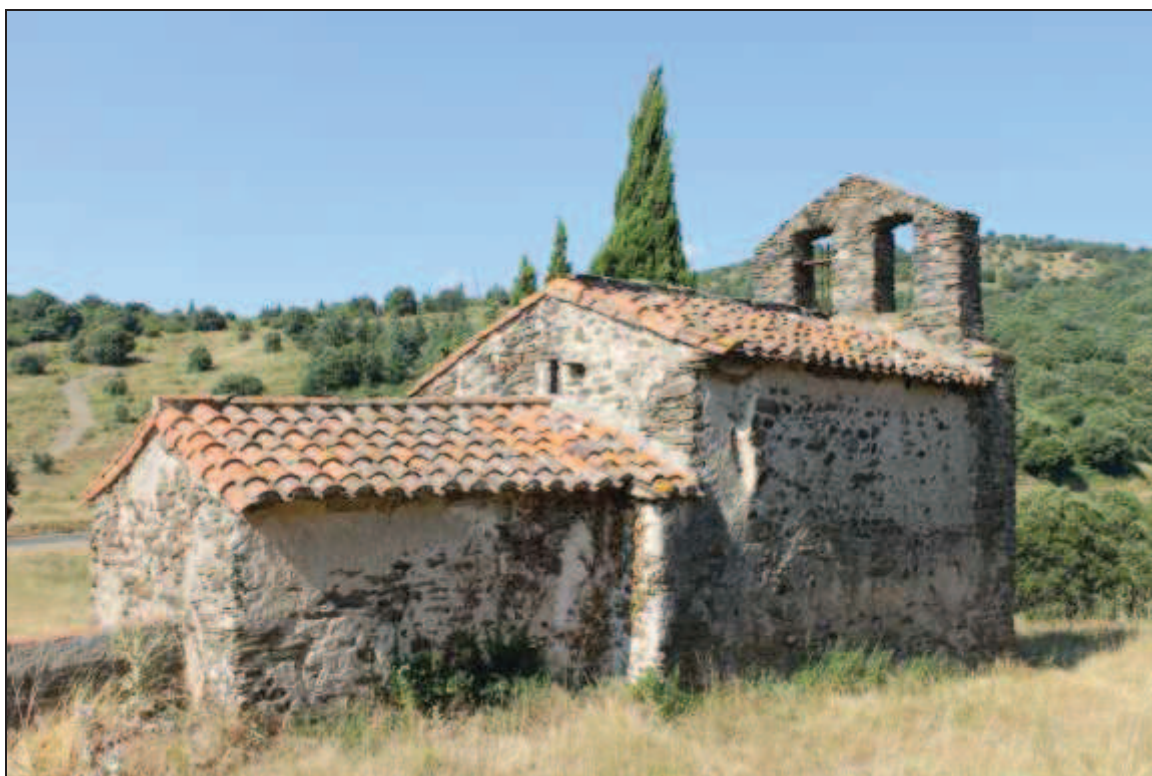
Façade méridionale (haut), et face septentrional (bas)
