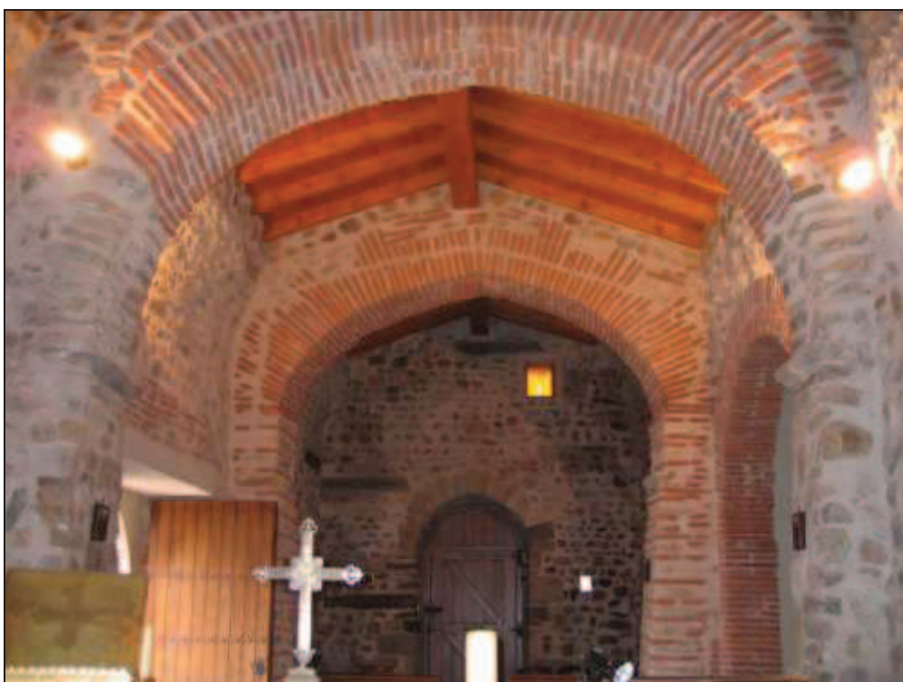
Nef d'ouest en est (haut), et d'est en ouest (bas)
