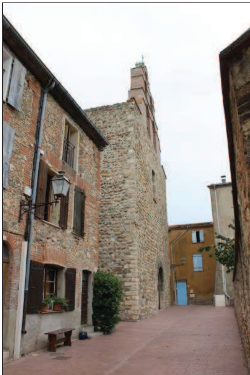
Façade occidentale vue depuis l'angle nord/ouest
