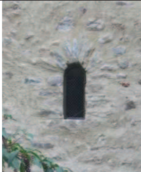
Baie est du mur gouttereau septentrional
