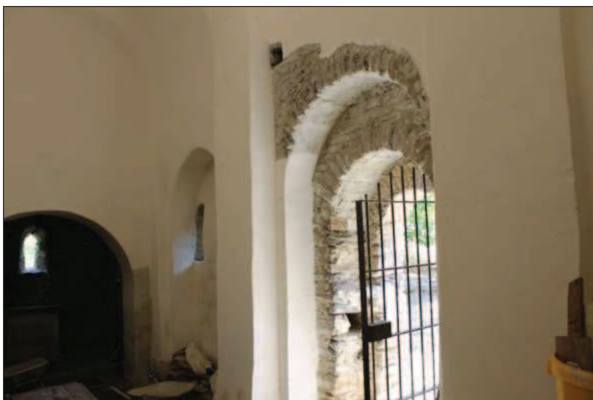
Mur gouttereau septentrional (haut), mur gouttereau méridional (bas)
