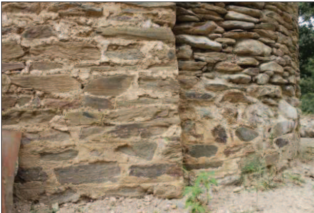
Chevet reconstruit sur les vestiges découverts lors des fouilles (haut), joints à la pointe de la truelle, angle sud de la rencontre entre le chevet et la nef (bas)
