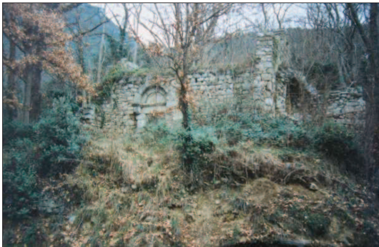
Façade méridionale avant restauration
