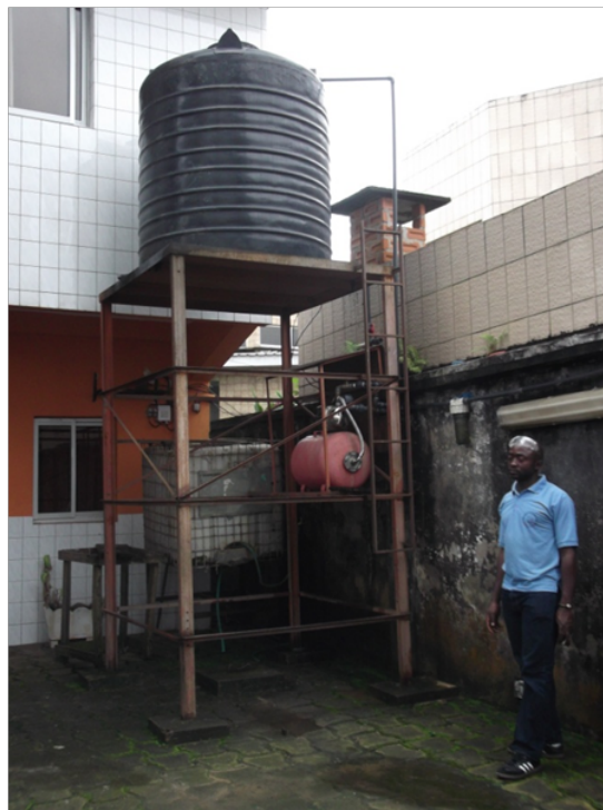
Planche photographique n° 13 : Des forages équipés de bâches
