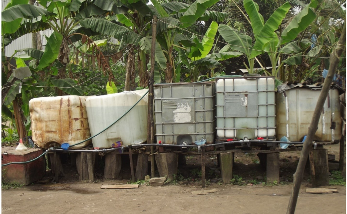
Photographie n° 6: Dispositif technique privé de stockage et de revente informelle d'eau à Mambanda
