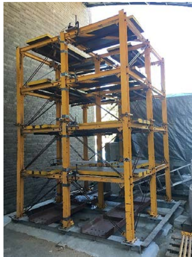
(a) Photo de la structure du Yellow Frame (coin sud-est)
