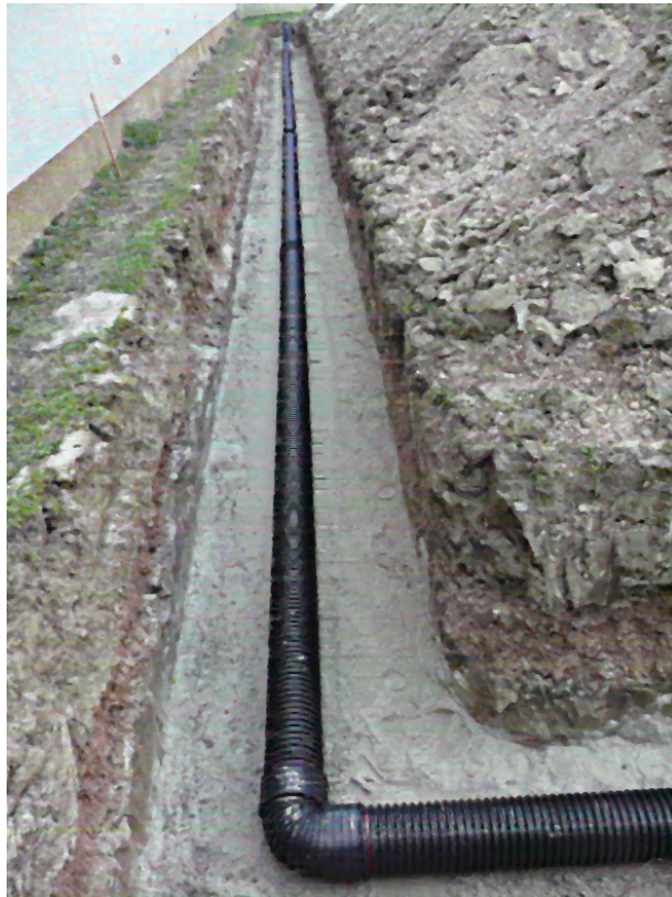
Figure 1.13 – Installation de l'échangeur air-sol sur son lit de pose.
