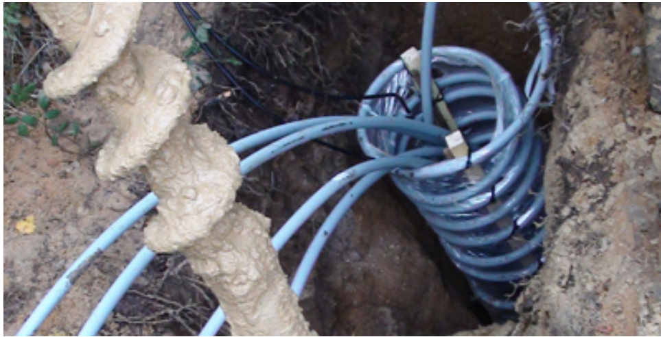
Figure 1.8 – Corbeille géothermique. Source : BRGM.
