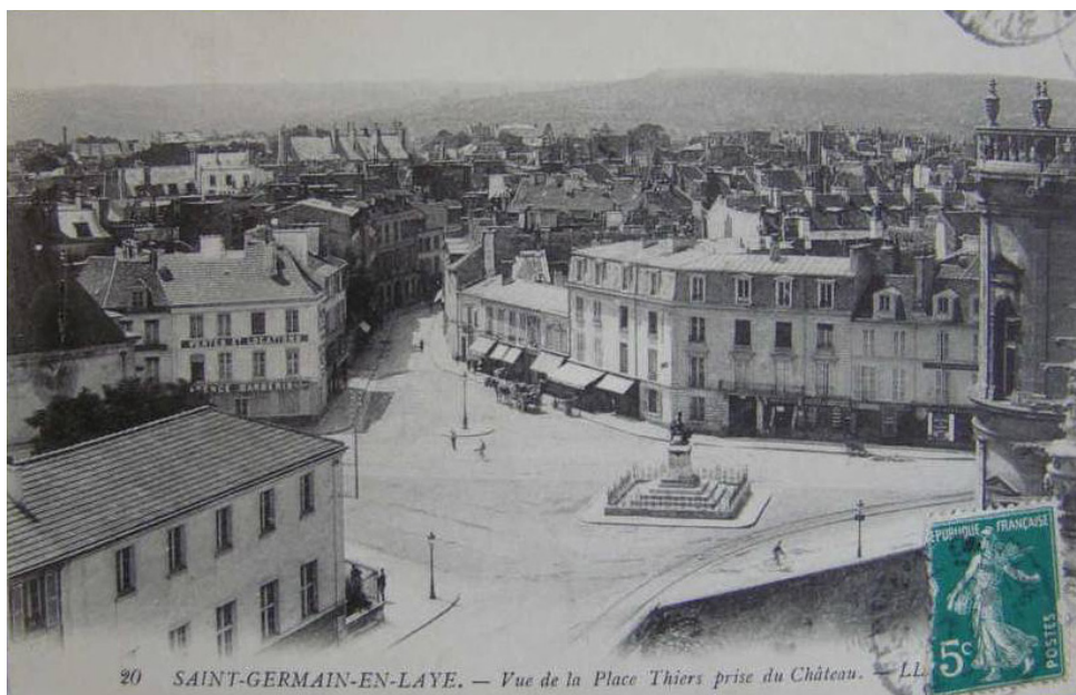
Fig. 49 : Vue de la place Thiers depuis le château les bâtiments des ateliers et du logement du chef d'atelier sont sur la gauche en face du château, carte postale, © MAN, archives.
