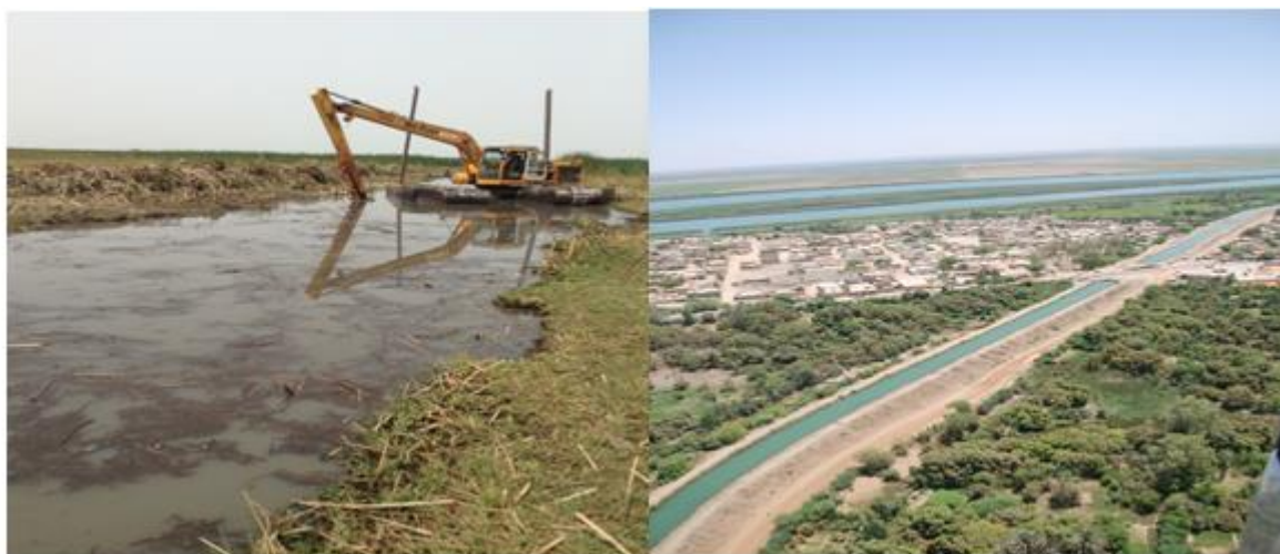
Photo 17-Travaux de curage faits par PREFELAG/OLAG ,2014
