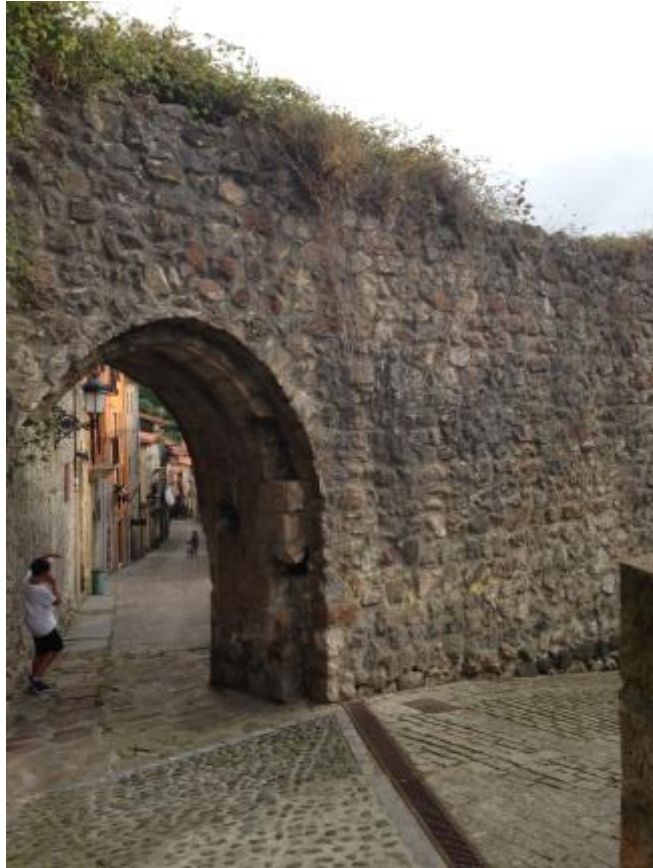
Figure 51. Fragment de la muraille de Laredo et porte du Merinillo 1039
