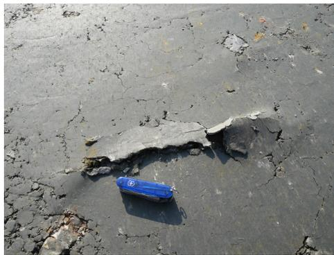
FIGURE 2.10 – Écaillage du plot 2BMV5 au-dessus des blocs
