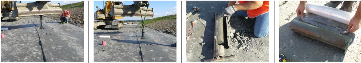
FIGURE 2.14 – Mode opératoire des carottages sur les plots de la planche
