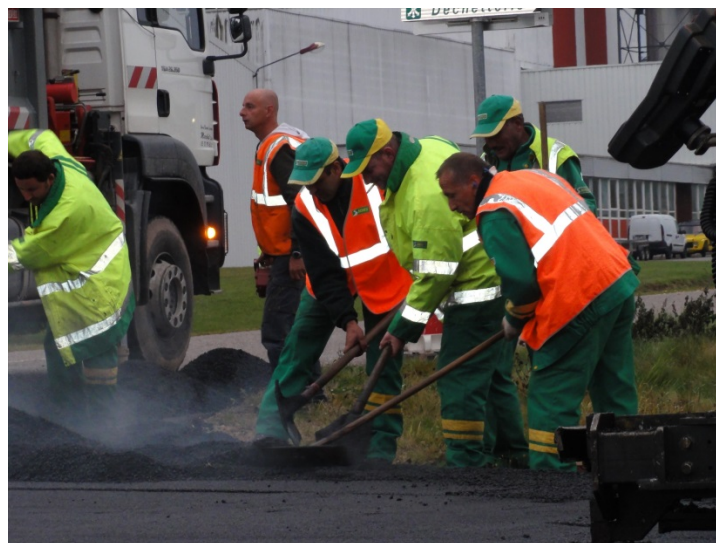
Figure 9 : Opérateurs répandant manuellement l'enrobé
