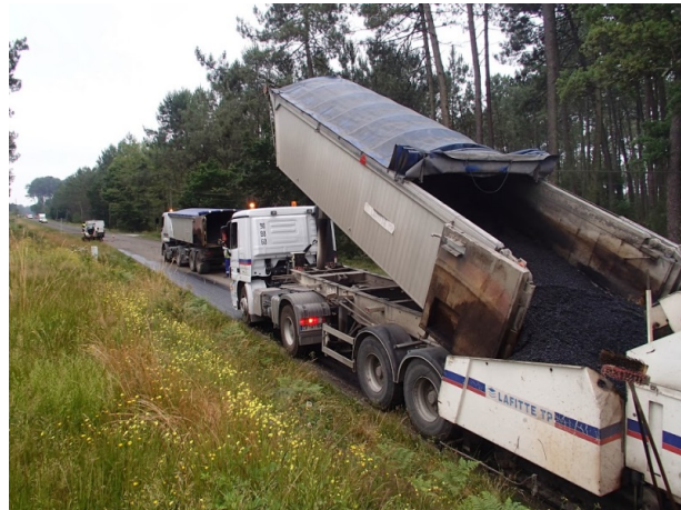
Figure 2 : Photographie d'un camion ravitailleur déversant l'enrobé dans la trémie d'un finisseur.
