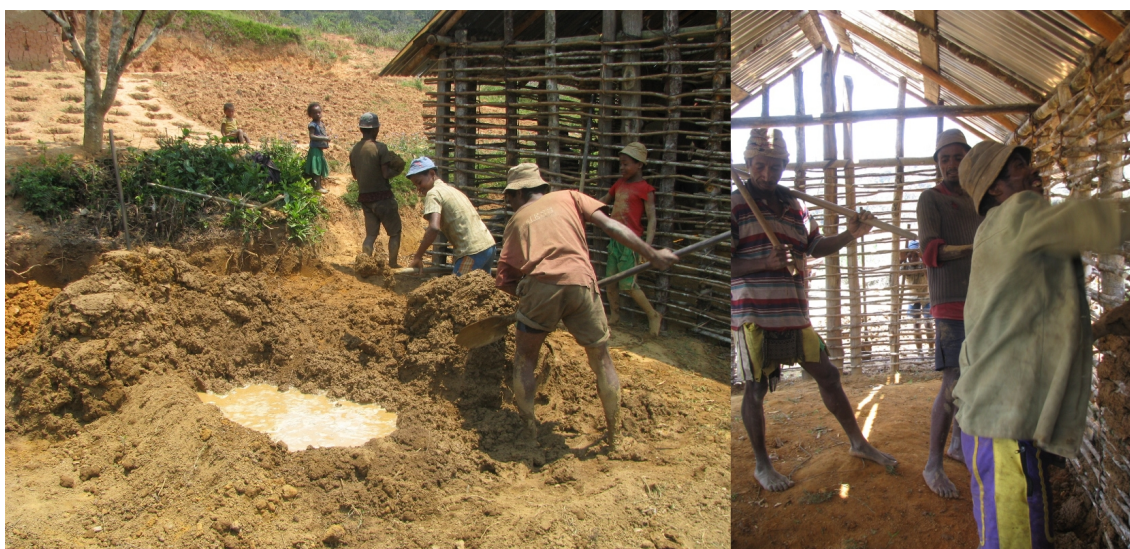
Photographie 3 : Reconstruction de l'école de Sahataitoaka suite à sa destruction par un cyclone (montage de 2 photographies)
