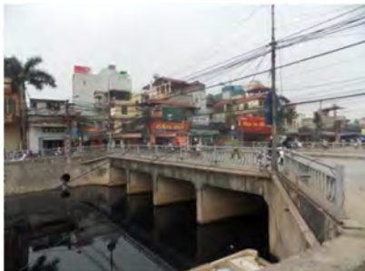
15 : Le pont Định Công relie le village inférieur Định Công Hạ, la section Giáp Bát et la route Giải Phóng et la route nationale 1 A. Cette route, existant depuis longtemps, est la route principale qui traverse le centre du village. L'architecture du pont n'est pas en lien avec l'histoire et la culture du village.
