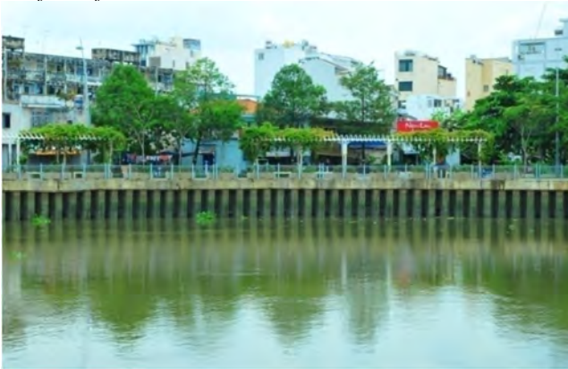
Le désordre est dû au processus d'urbanisation d'une époque hors de contrôle : absence de maîtrise et de gestion de l'aménagement urbain de manière responsable et sérieuse. Il est possible de maintenir certains espaces représentatifs de valeur historique pour en faire une caractéristique paysagère du secteur concerné. Photos: ĐỒ Xuân Sơn
