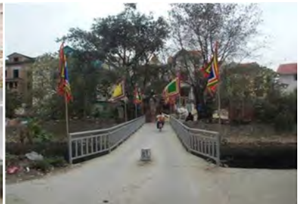
18 : Le passage conduit au temple Mẫu dâm Sen et au village Đại Từ . On a beaucoup parlé du pont par le passé, car il relie le village à l'île où se trouve le temple Mẫu sur le lac. Les processions des saints passent par ce pont, même s'il a, au fil du temps, adopté différentes formes.
