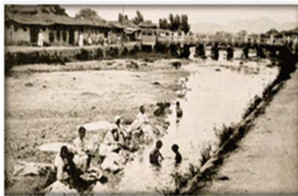
Au début du XIX e siècle, le ruisseau, propre, fut le lieu où les habitants de Séoul se lavèrent eux-mêmes et lavèrent leur linge. Le vieux pont et les anciennes maisons d'un seul étage ont été construits le long du ruisseau. Les constructions n'envahirent pas les berges. 3
