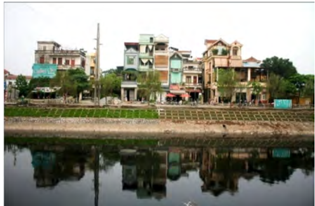
Photo : Une partie de la façade de la rivière et village Định Công Hạ avec le permis de construire. Il n'y a pas une norme-une règle sur la hauteur, le volume de l'ensemble des bâtiments. Photo : ĐỖ Xuân Sơn
