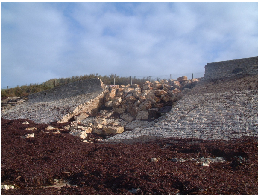
Figure 54. Réparation d'urgence de la digue des Doreaux à Saint-Clément-des-Baleines (Photo : Jean Maurin, 05/11/02)
