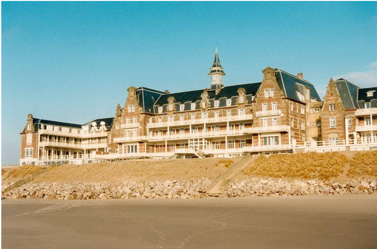
Illustration 3 : Photo de Berck, premier sanatorium édifié en France 7
