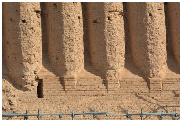
Fig. 67 : Grand Kyz Kala. Réparation des parties déchaussées à la base des colonnes semi engagées de la façade sud. (©CRAterre, C. Sadozai, 2015)
