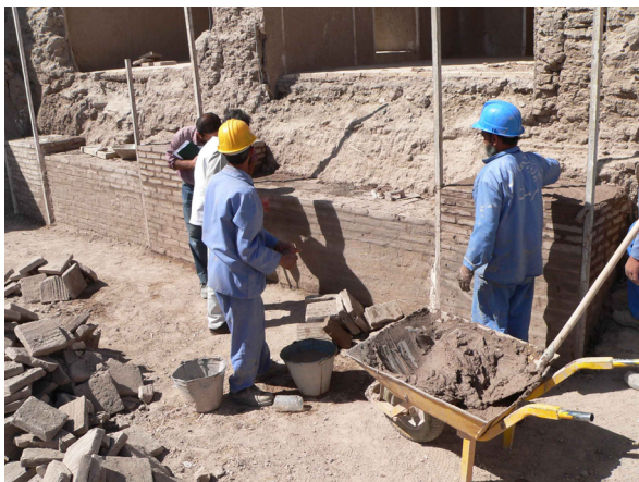
Fig. 126 : liaisonnement systématique des reprises de maçonneries avec le support existant. (©CRAterre, T. Joffroy, 2006)
