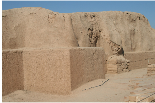
Fig. 112 : décollement de l'enduit sacrificiel. (©CRAterre, D. Gandreau, 2017)
