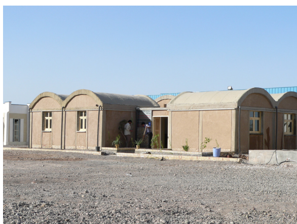
Fig. 120 : prototype d'habitat réalisé par CRATERre dans le cadre de la reconstruction de la ville moderne de Bam. Réalisé en partie en briques de terre crue, il reprend des principes parasismiques observés dans la construction traditionnelle locale. (©CRATERre, P. Garnier, 2006)
