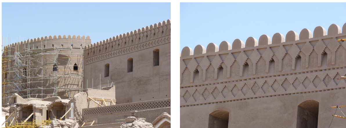
Fig. 130 : crénelages et frises de décors muraux en bas-relief reconstruits. (©CRAterre, S. Moriset, 2010)
