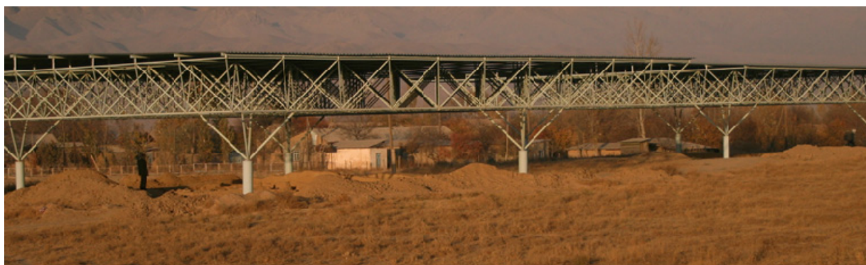
Fig. 73 : couvertures métalliques installées en 2005 sur le site de Sarazm. (©CRAterre, D. Gandreau, 2007)
