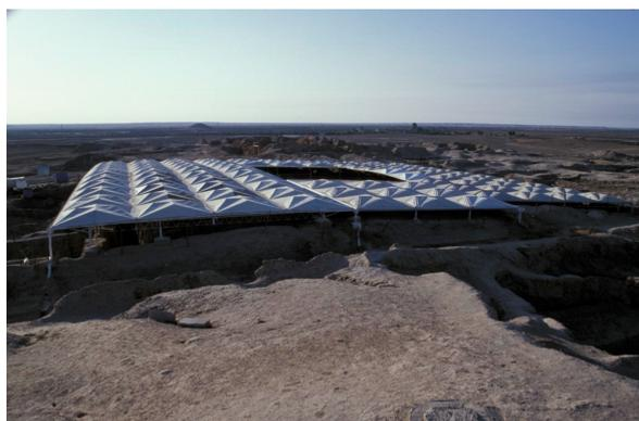
Fig. 32 : Mari. Vue de la couverture installée en 1974 pour protéger les vestiges d'un palais du III<sup>ème</sup> millénaire avant notre ère (©CRAterre, Mahmoud Bendakir)
