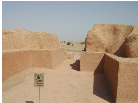
Fig. 111 : détail de traitement des murs avec enduits sacrificiels et reprise de la base en maçonnerie. (©CRAterre, D. Gandreau, 2006)
