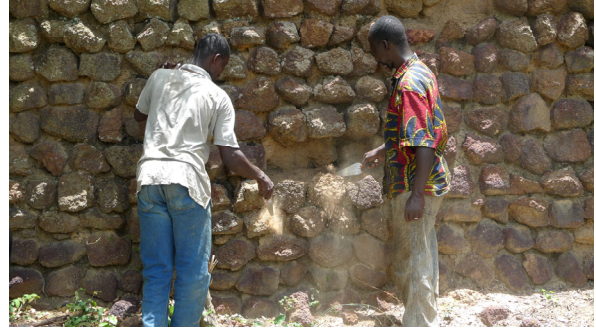
Fig. 140 : bouchage de trous dans les murs. (©CRAterre, D. Gandreau, 2010)
