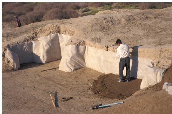
Fig. 58 : Shahryar Ark. Expérimentation de techniques de ré-enfouissement avec un géotextile et des couches de terre damée (Bendakir et al. 2003). (©CRAterre, M. Bendakir, 2002)
