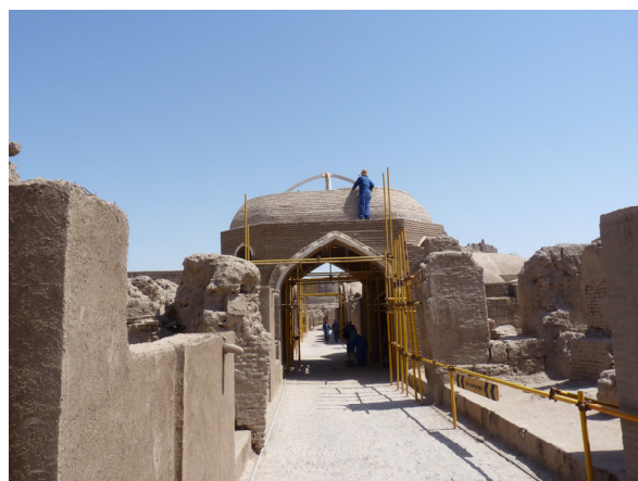
Fig. 128 : reconstruction de voûtes en 2010. (©CRAterre, S. Moriset, 2010)
