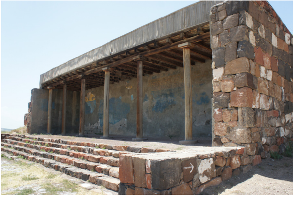
Fig. 6 : Erébouni, Arménie. Forteresse royale fondée en 782 avant J.C par le roi d'Ourartou Arguichti Ier. Plusieurs édifices monumentaux aux élévations en briques de terre crue ont été restaurés avec des pierres et du ciment sans justification scientifique sous la période soviétique. Un projet actuel porté par la ville d'Erevan et le directeur du site vise à revaloriser les élévations d'origine en terre. (©CRATERre, D. Gandreau, 2015)
