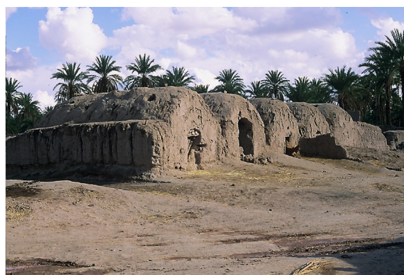
Fig. 119 : habitat voûté en terre dans la palmeraie de Baravat, à l'est de Bam, ayant résisté au séisme de 2003. Ce type d'habitat témoigne de cultures constructives intégrant les matériaux locaux et les principes de construction parasismiques. (©CRATERre, D. Gandreau, 2005)
