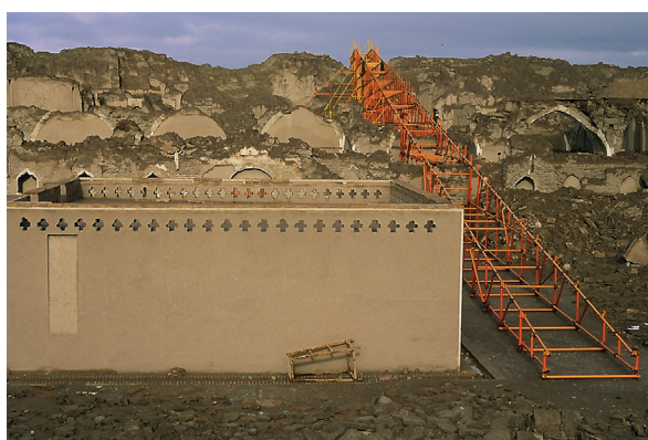
Fig. 121 : le retrait des débris depuis l'intérieur de la citadelle vers l'extérieur a été réalisé grâce à des rampes en tubes d'échafaudages sur lesquelles ont été disposés des tapis en caoutchouc, actionnés par des rouleaux motorisés. Une partie des débris a aussi été évacuée par la porterie sud. (©CRAterre, D. Gandreau, 2005)
