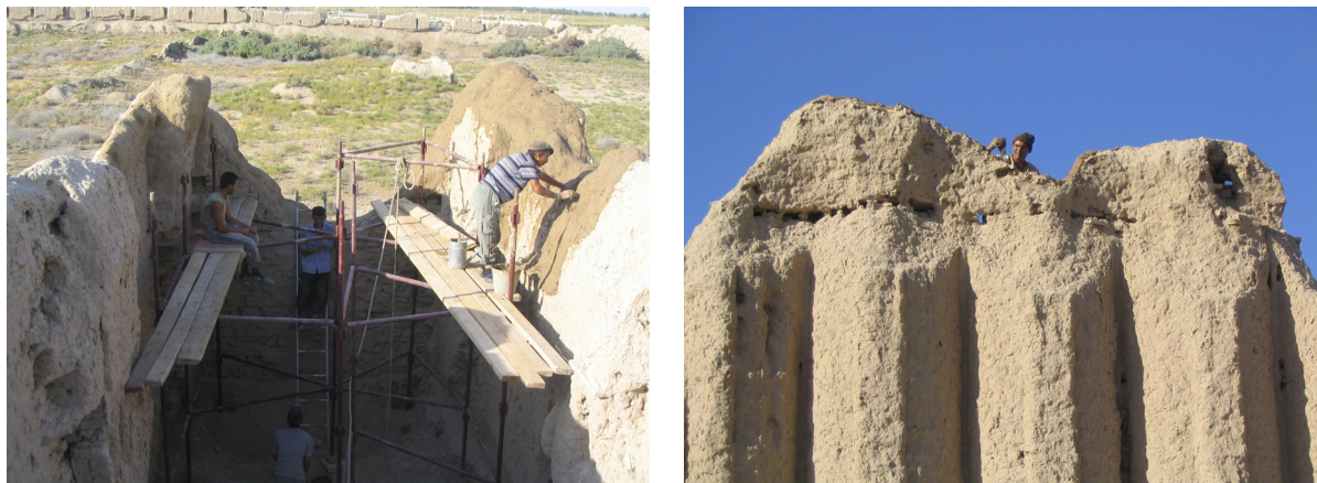
Fig. 62 : Kepter Khana. Pose d'un enduit sacrificiel sur le sommet des murs. (@CRAterre, D. Gandreau, 2005)
