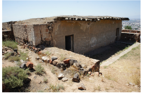
Fig. 6 : Erébouni, Arménie. Forteresse royale fondée en 782 avant J.C par le roi d'Ourartou Arguichti Ier. Plusieurs édifices monumentaux aux élévations en briques de terre crue ont été restaurés avec des pierres et du ciment sans justification scientifique sous la période soviétique. Un projet actuel porté par la ville d'Erevan et le directeur du site vise à revaloriser les élévations d'origine en terre. (©CRATERre, D. Gandreau, 2015)
