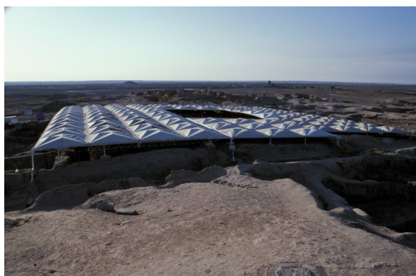
Fig. 32 : Mari. Vue de la couverture installée en 1974 pour protéger les vestiges d'un palais du III ème millénaire avant notre ère (©CRAterre, Mahmoud Bendakir)
