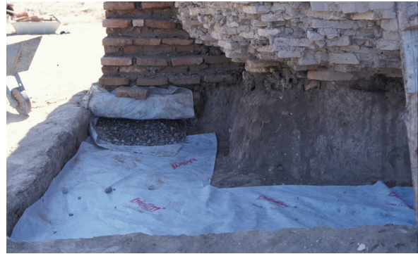
Fig. 64 : Kepter Khana. Des expériences ont été réalisées en 2003 et 2004 afin de créer des barrières capillaires en creusant sous les murs de vestiges devant être repris à la base afin d'insérer une couche d'environ 40 cm de cailloux recouverte d'un géotextile. (©CRATERRE, D. Gandreau, 2004)
