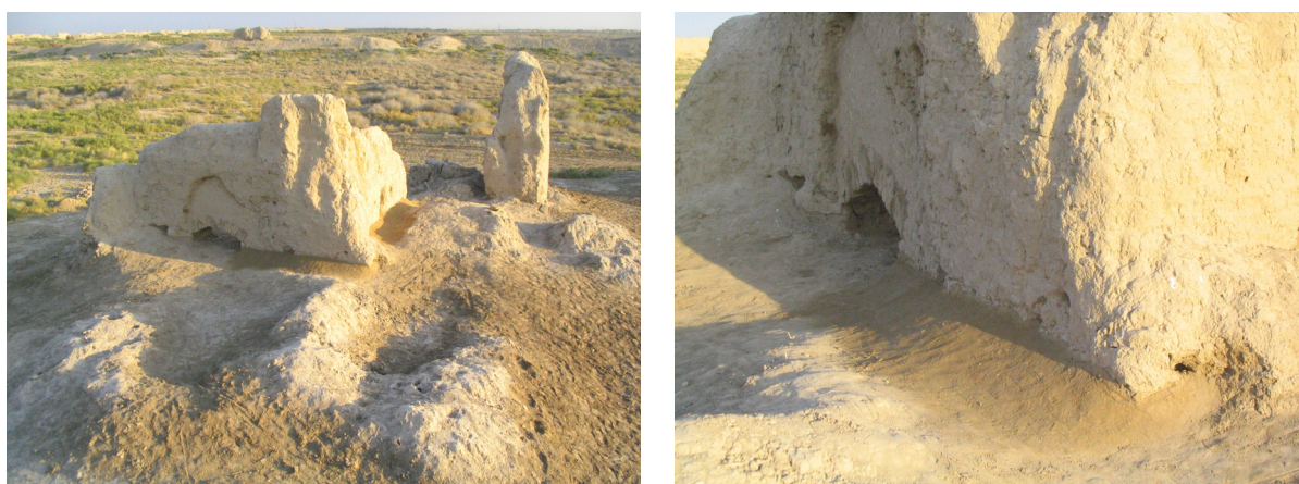
Fig. 63 : Kepter Khana. Drainage de surface. (@CRAterre, D. Gandreau, 2005)
