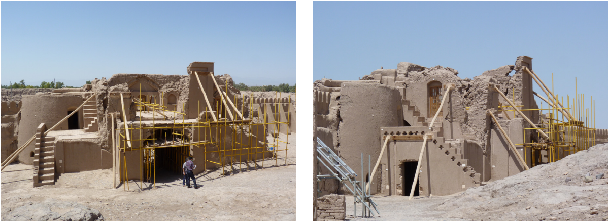
Fig. 123 : à mesure que les débris ont été évacués, les structures fragilisées ont été étayées. (©CRAterre, S. Moriset, 2007)
