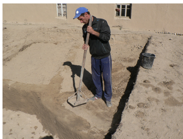
Fig. 88 : secteur XVI. Protection des sols avec une terre damée, en couvrant d'un textile poreux les traces les plus fragiles. (©CRAterre, D. Gandreau, 2012)
