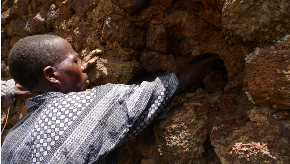
Fig. 140 : bouchage de trous dans les murs. (©CRAterre, D. Gandreau, 2010)
