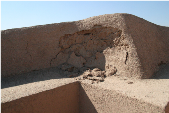
Fig. 112 : décollement de l'enduit sacrificiel. (©CRAterre, D. Gandreau, 2017)
