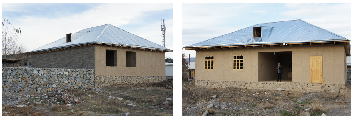
Fig. 80 : maison contemporaine à Pendjikent, dont les murs, élevés sur un soubassement en pierre, sont en adobes recouverts d'un enduit en terre et paille. (@CRAterre, D. Gandreau, 2012)
