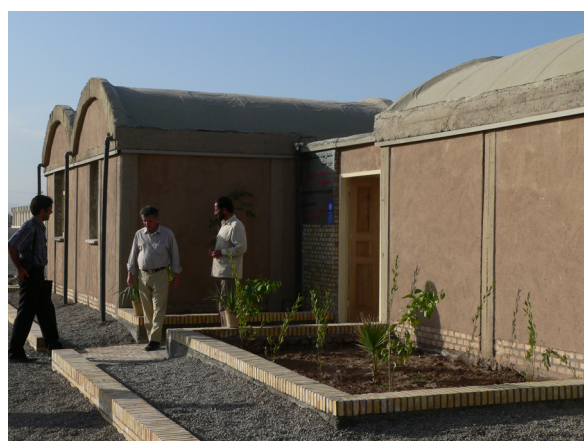
Fig. 120 : prototype d'habitat réalisé par CRATERre dans le cadre de la reconstruction de la ville moderne de Bam. Réalisé en partie en briques de terre crue, il reprend des principes parasismiques observés dans la construction traditionnelle locale. (©CRATERre, P. Garnier, 2006)
