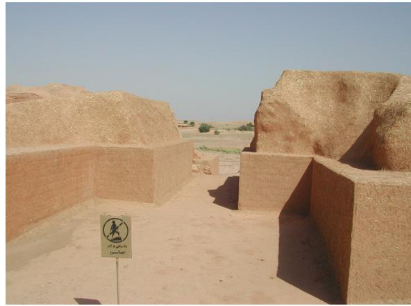
Fig. 111 : détail de traitement des murs avec enduits sacrificiels et reprise de la base en maçonnerie.
