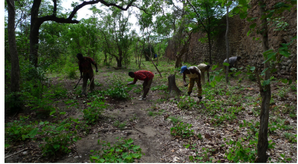
Fig. 139 : retrait méthodique et sélectif de la végétation. (©CRAterre, D. Gandreau, 2010)
