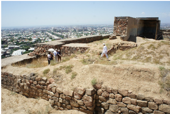
Fig. 18 : Erébouti. Vue du site depuis le sud. Les soubassements des murs sont en appareillage de pierres équarées et les élévations en briques de terre crue. (@CRAterre, D. Gandreau, 2014)
