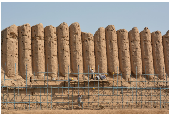
Fig. 67 : Grand Kyz Kala. Réparation des parties déchaussées à la base des colonnes semi engagées de la façade sud. (©CRAterre, C. Sadozai, 2015)
