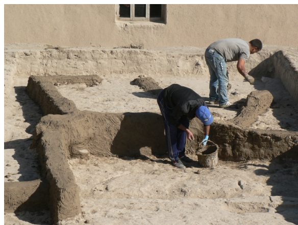
Fig. 87 : secteur XVI. Protection des murs fouillés avec un enduit terre/balle de riz/paille. (©CRAterre, D. Gandreau, 2012)
