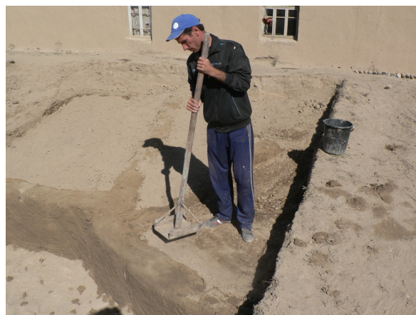
Fig. 88 : secteur XVI. Protection des sols avec une terre damée, en couvrant d'un textile poreux les traces les plus fragiles. (©CRAterre, D. Gandreau, 2012)
