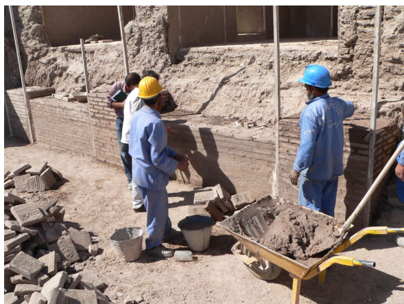
Fig. 126 : liaisonnement systématique des reprises de maçonneries avec le support existant. (©CRAterre, T. Joffroy, 2006)
