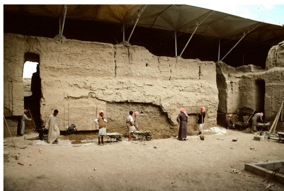
Fig. 33 : Mari. Vestiges du palais du III ème millénaire avant notre ère protégés par la couverture métallique. (©CRAterre, Mahmoud Bendakir)
