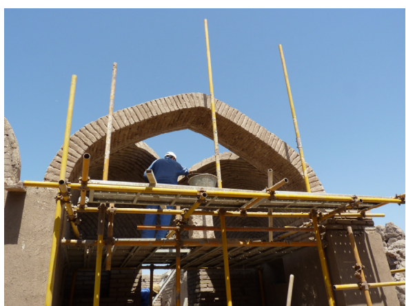
Fig. 128 : reconstruction de voûtes en 2010. (©CRAterre, S. Moriset, 2010)
