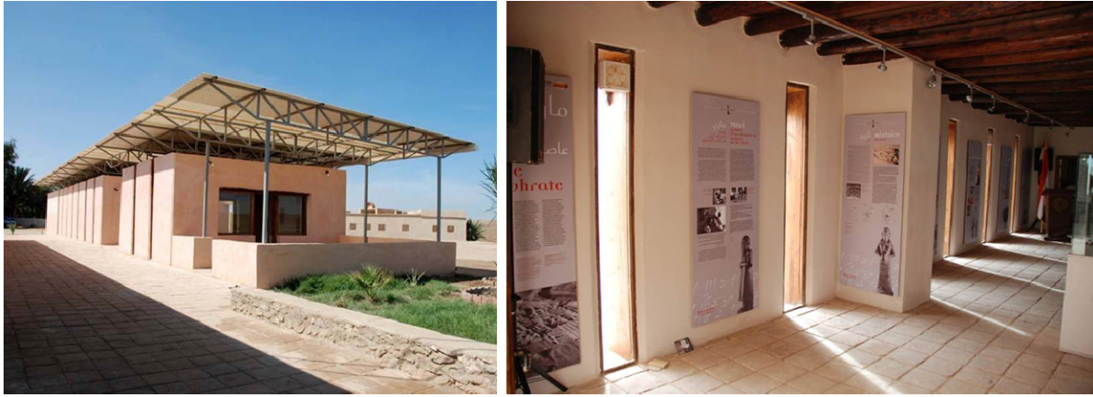
Fig : 149 : Mari : le centre d'interprétation construit en terre crue (briques, pisé et enduits). (©CRAterre, M. Bendakir, 2010)
