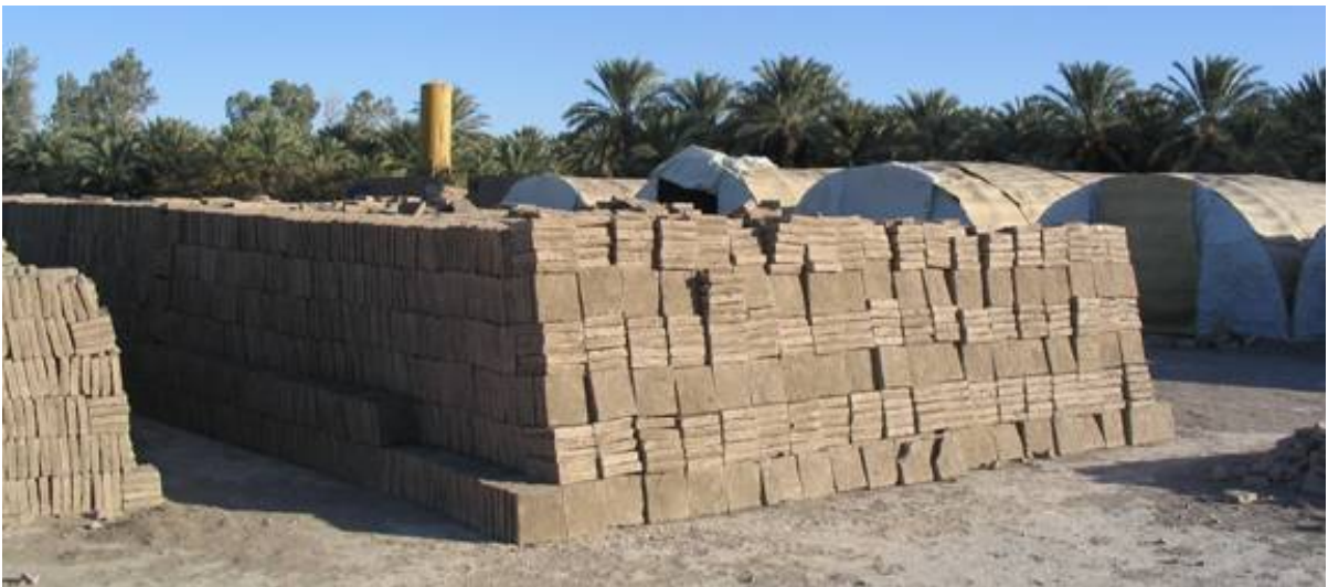
Fig. 124 : production de briques de terre crue de qualité en grande quantité. (©CRAterre, D. Gandreau, 2005)
