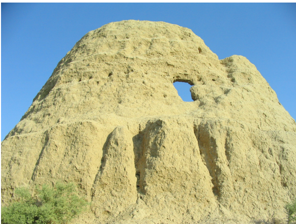
Fig. 65 : Glacière 2. Réparation d'un trou apparu dans la maçonnerie. (©CRATERRE, D. Gandreau, 2004)
