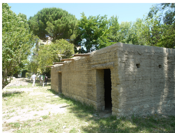
Fig. 4 : construction grandeur réelle d'une maison gauloise du II ème siècle av. n. è. dans le parc archéologique de Lattara. Les élévations sont restituées en terre. (©CRAterre, Th. Joffroy, 2014)
