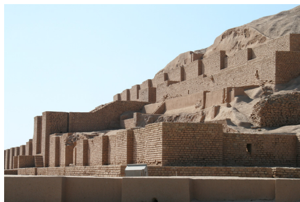
Fig. 31 : Tchoğa Zanbil. Détail des parements en briques cuites de la face sur-est de la ziggourat, remontés au moment des fouilles de 1951 - 1966. (©CRAterre, D. Gandreau, 2017)
