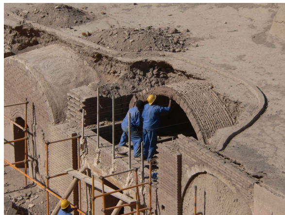
Fig. 127 : reconstruction d'une voûte en 2006. (©CRAterre, T. Joffroy, 2006)
