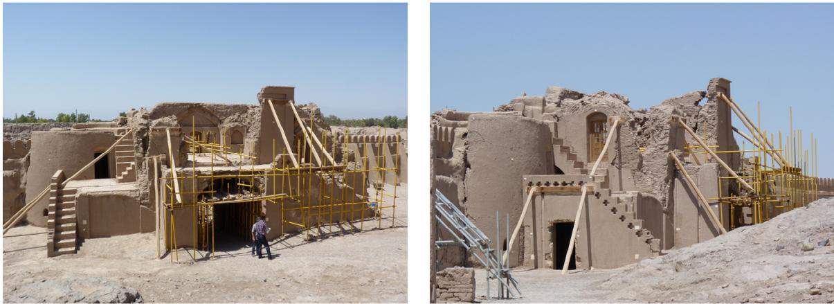
Fig. 123 : à mesure que les débris ont été évacués, les structures fragilisées ont été étayées.
