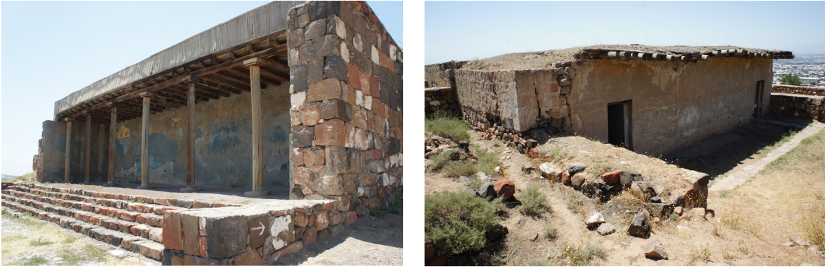
Fig. 6 : Erébouni, Arménie. Forteresse royale fondée en 782 avant J.C par le roi d'Ourartou Arguichti Ier. Plusieurs édifices monumentaux aux élévations en briques de terre crue ont été restaurés avec des pierres et du ciment sans justification scientifique sous la période soviétique. Un projet actuel porté par la ville d'Erevan et le directeur du site vise à revaloriser les élévations d'origine en terre. (©CRAterre, D. Gandreau, 2015)
