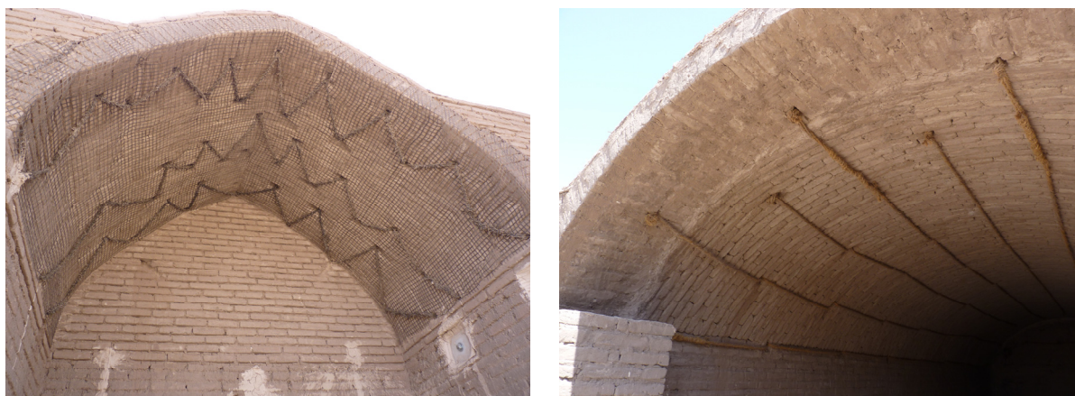
Fig. 129 : insertion de cordes en fibres de palmier dans les voûtes. (©CRAterre, S. Moriset, 2010)
