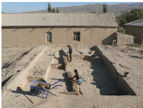
Fig. 87 : secteur XVI. Protection des murs fouillés avec un enduit terre/balle de riz/paille. (©CRAterre, D. Gandreau, 2012)
