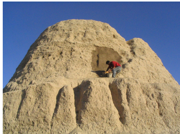
Fig. 65 : Glacière 2. Réparation d'un trou apparu dans la maçonnerie. (©CRATERRE, D. Gandreau, 2004)
