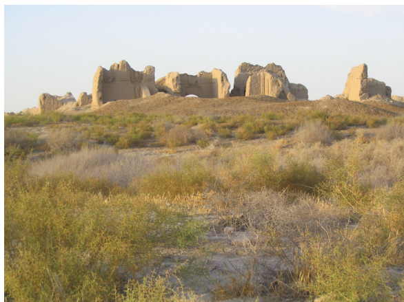
Fig. 51 : vestiges affleurants du palais de Shahryar Ark préservé dans un état de ruine avancée, mais dont les murs et la distribution architecturale restent identifiables. (©CRAterre, D. Gandreau, 2007)
