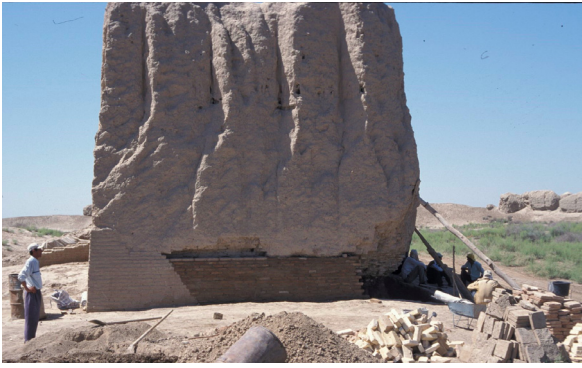
Fig. 64 : Kepter Khana. Des expériences ont été réalisées en 2003 et 2004 afin de créer des barrières capillaires en creusant sous les murs de vestiges devant être repris à la base afin d'insérer une couche d'environ 40 cm de cailloux recouverte d'un géotextile. (©CRATERRE, D. Gandreau, 2004)
