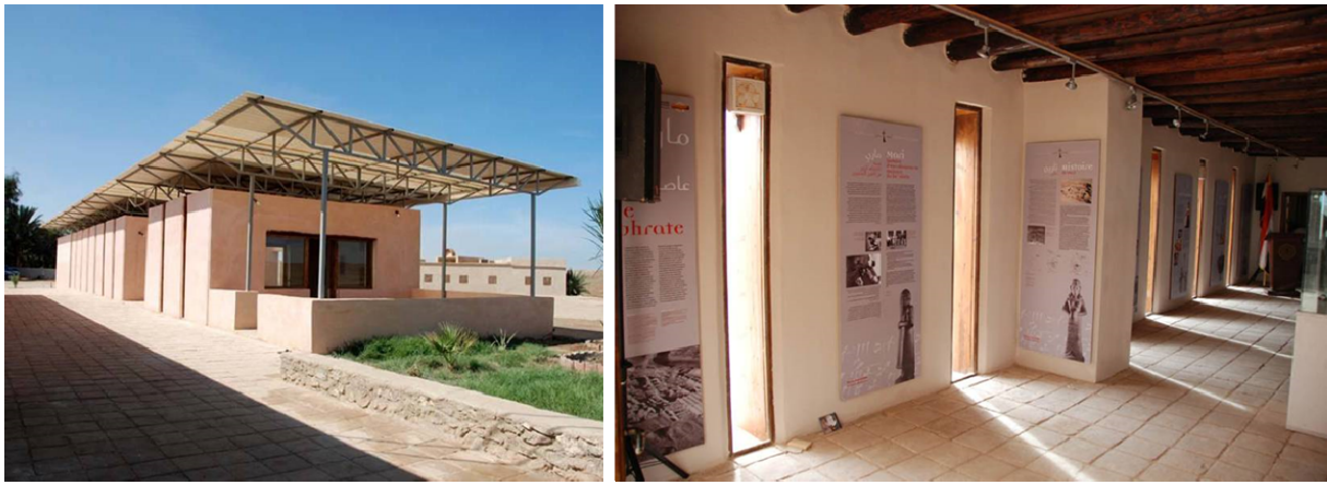
Fig : 149 : Mari : le centre d'interprétation construit en terre crue (briques, pisé et enduits). (©CRAterre, M. Bendakir, 2010)
