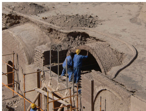
Fig. 127 : reconstruction d'une voûte en 2006. (©CRAterre, T. Joffroy, 2006)
