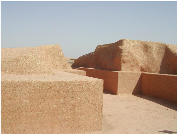
Fig. 111 : détail de traitement des murs avec enduits sacrificiels et reprise de la base en maçonnerie. (©CRAterre, D. Gandreau, 2006)
