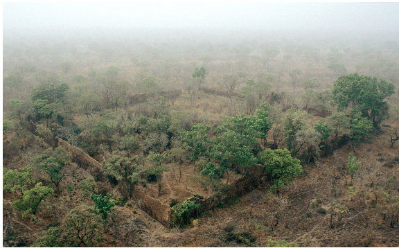
Fig. 11 : Loropéni. Vue aérienne des ruines. (©CRAterre, T. Joffroy, 2005)
