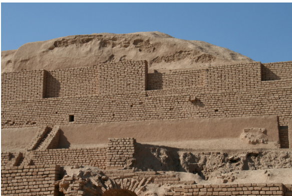
Fig. 108 : détail du parement restauré de la ziggourat. (©CRAterre, D. Gandreau, 2017)
