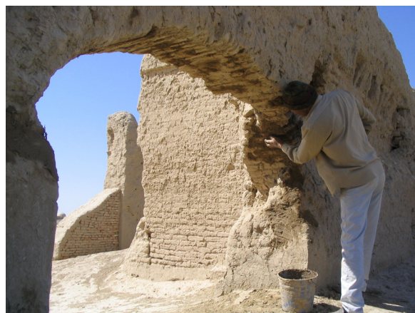
Fig. 61 : Shahriyar Ark. Consolidation des parties fragilisées des murs avec un mortier de terre. (©CRAterre, D. Gandreau, 2005)
