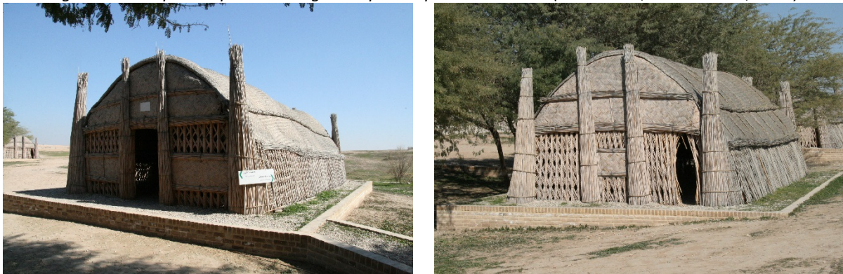
Fig. 114 : structures bâties en roseau rappelant l’habitat végétal représenté sur la céramique élamite. L’une sert de mosquée et l’autre de lieu de réunion (@CRAtterre, D. Gandreau, 2017)
