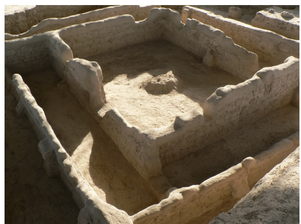
Fig. 86 : secteur XI. Des enduits sacrificiels réalisés en deux couches sur les sommets des murs sont effectués avec le mélange de terre décrit plus haut. La mise en œuvre commence par le retrait des parties décollées en surface afin de retrouver un support dur et cohésif sur lequel sera appliqué l'enduit de protection. Il s'agit de retirer les parties pulvérulentes qui se décrochent du mur afin d'assurer que l'enduit viendra adhérer sur un support sain. Cette opération se fait délicatement à la main et avec un balai ou une brosse souple. (©CRAterre, D. Gandreau, 2013)
