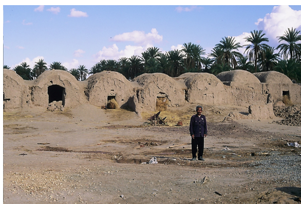
Fig. 119 : habitat voûté en terre dans la palmeraie de Baravat, à l'est de Bam, ayant résisté au séisme de 2003. Ce type d'habitat témoigne de cultures constructives intégrant les matériaux locaux et les principes de construction parasismiques. (©CRATERre, D. Gandreau, 2005)
