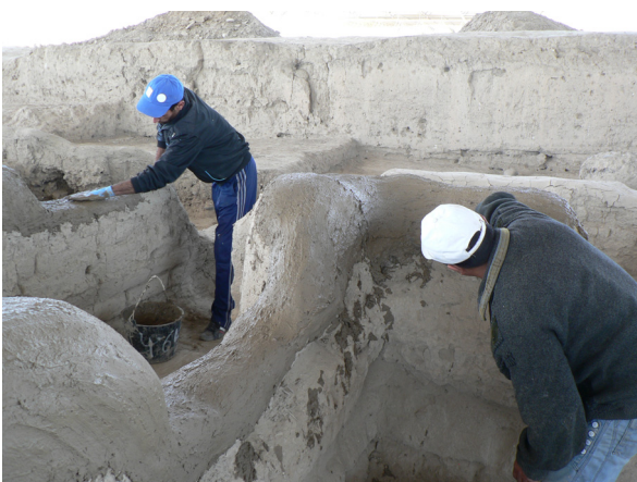
Fig. 86 : secteur XI. Des enduits sacrificiels réalisés en deux couches sur les sommets des murs sont effectués avec le mélange de terre décrit plus haut. La mise en œuvre commence par le retrait des parties décollées en surface afin de retrouver un support dur et cohésif sur lequel sera appliqué l'enduit de protection. Il s'agit de retirer les parties pulvérulentes qui se décrochent du mur afin d'assurer que l'enduit viendra adhérer sur un support sain. Cette opération se fait délicatement à la main et avec un balai ou une brosse souple. (©CRAterre, D. Gandreau, 2013)
