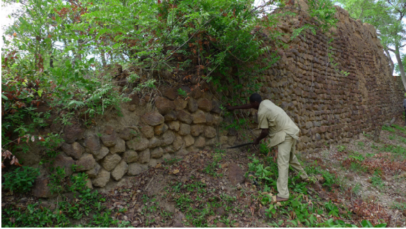
Fig. 139 : retrait méthodique et sélectif de la végétation. (©CRAterre, D. Gandreau, 2010)
