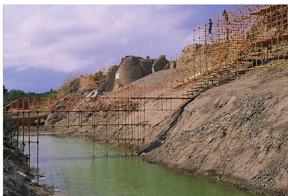
Fig. 122 : des échafaudages ont été disposés afin de permettre un accès sécurisé à l'ensemble du site. (©CRAterre, D. Gandreau, 2005)
