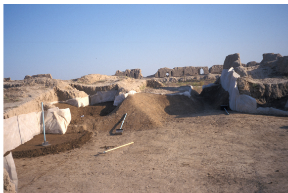
Fig. 58 : Shahryar Ark. Expérimentation de techniques de ré-enfouissement avec un géotextile et des couches de terre damée (Bendakir et al. 2003). (©CRAterre, M. Bendakir, 2002)
