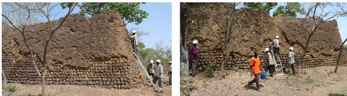
Fig. 135 : murs de l'enceinte de Loropéni, élevés sur six mètres de hauteur. (©CRATERRE, D. Gandreau, 2009)
