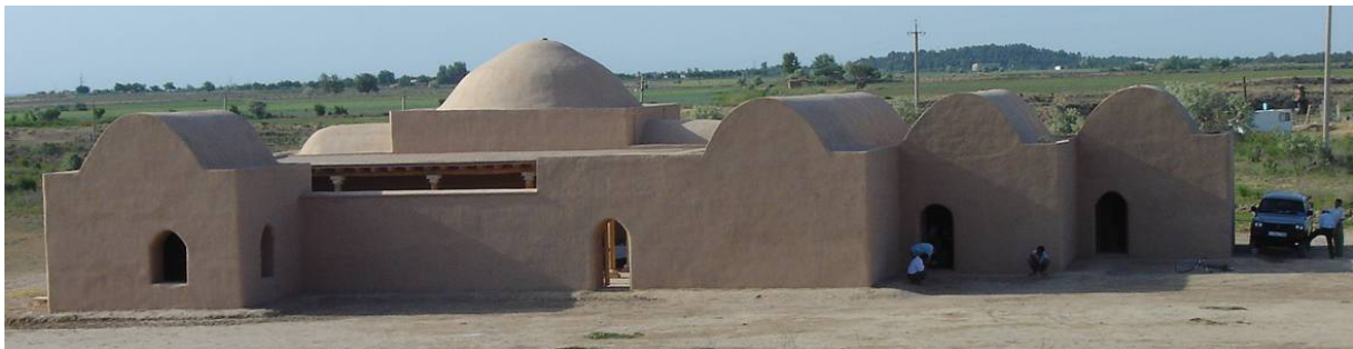
Fig. 148 : Fayaz Tepa : le centre d'interprétation construit en terre crue (briques et enduits). (©CRAterre, M. Bendakir, 2006)
