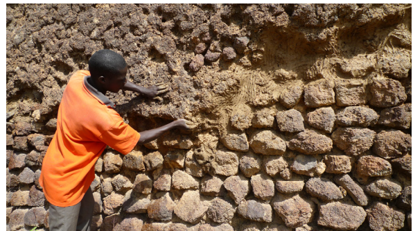
Fig. 141 : traitement des enduits. (©CRAterre, D. Gandreau, 2010)
