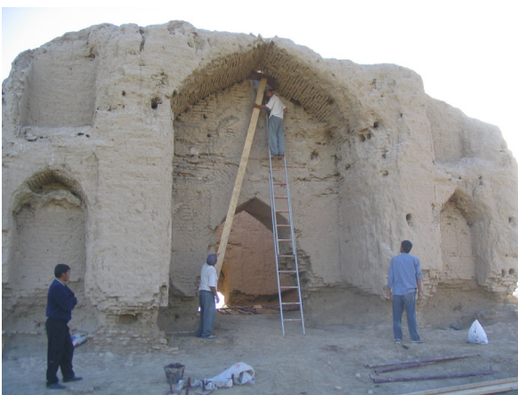
Fig. 66 : Pavillon Timouride. Réparation d'un trou dans la voûte de l'iwan principal. (©CRATERRE, D. Gandreau, 2004)
