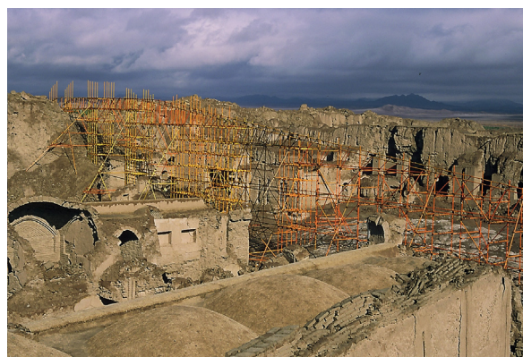
Fig. 122 : des échafaudages ont été disposés afin de permettre un accès sécurisé à l'ensemble du site. (©CRAterre, D. Gandreau, 2005)
