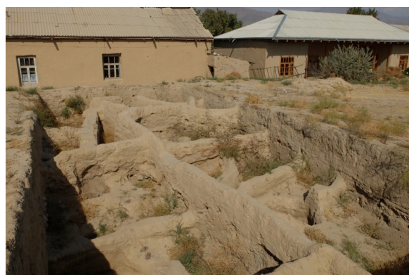
Fig. 82 : secteur 16. Secteur laissé sans protection après la fouille de 2014. (©CRAterre, C. Sadozai, 2015)
