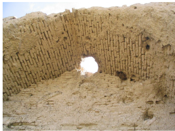
Fig. 66 : Pavillon Timouride. Réparation d'un trou dans la voûte de l'iwan principal. (©CRATERRE, D. Gandreau, 2004)
