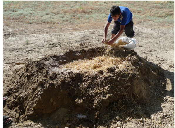
Fig. 84 : mélange de terre, paille et balle de riz. (©CRAterre, D. Gandreau, 2013)
