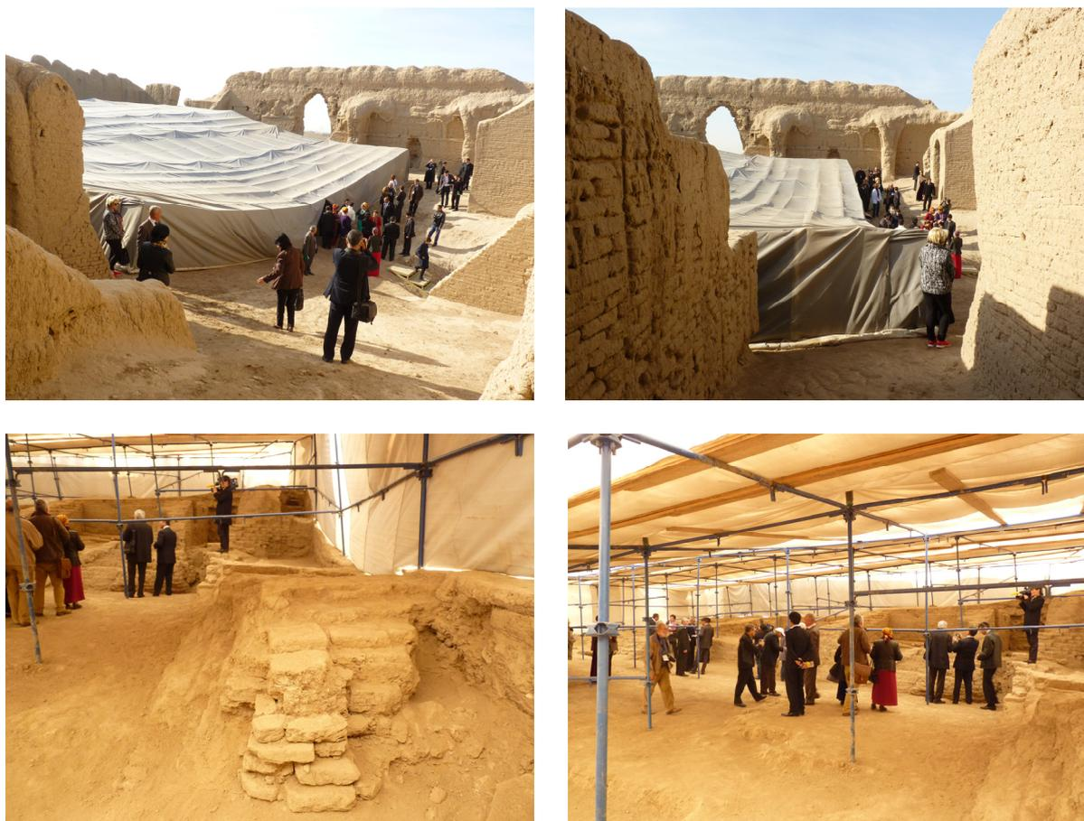
Fig. 55 : Grand Kyz Kala. Mesures de protection temporaire pendant les fouilles réalisées en été 2013 avec une structure en échafaudage métallique recouverte de bâches textiles. (©CRAterre, S. Moriset, 2013)
