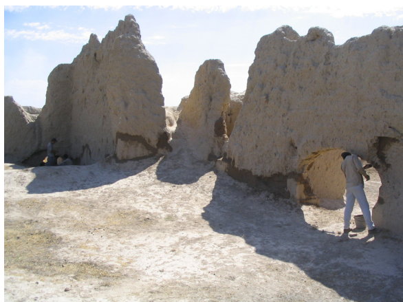
Fig. 61 : Shahriyar Ark. Consolidation des parties fragilisées des murs avec un mortier de terre. (©CRAterre, D. Gandreau, 2005)
