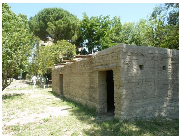
*Fig. 4 : construction grandeur réelle d'une maison gauloise du II<sup>ème</sup> siècle av. n. è. dans le parc archéologique de Lattara. Les élévations sont restituées en terre. (©CRAterre, Th. Joffroy, 2014)*
