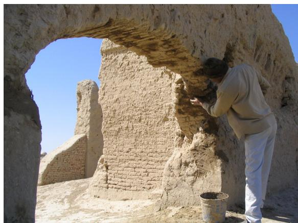
Fig. 61 : Shahryar Ark. Consolidation des parties fragilisées des murs avec un mortier de terre. (©CRAterre, D. Gandreau, 2005)
