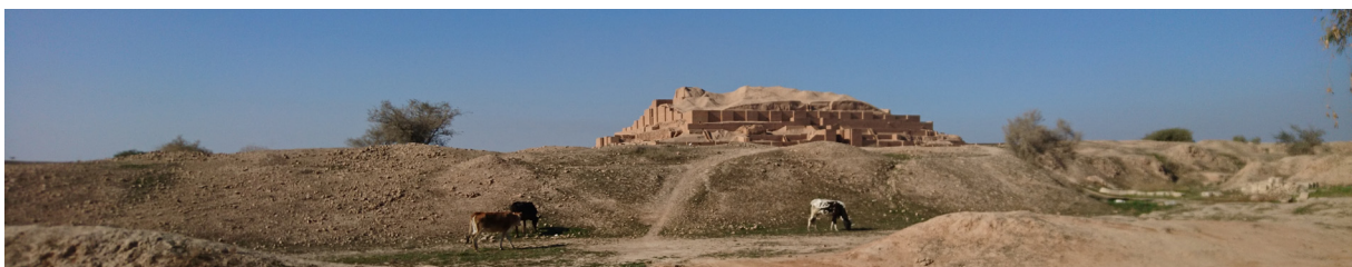
Fig. 93 : vue de la ziggourat depuis le sud. (©CRATERre, D. Gandreau, 2017)
