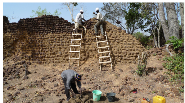
Fig. 142 : traitement des sommets des murs. (©CRAterre, D. Gandreau, 2010)
