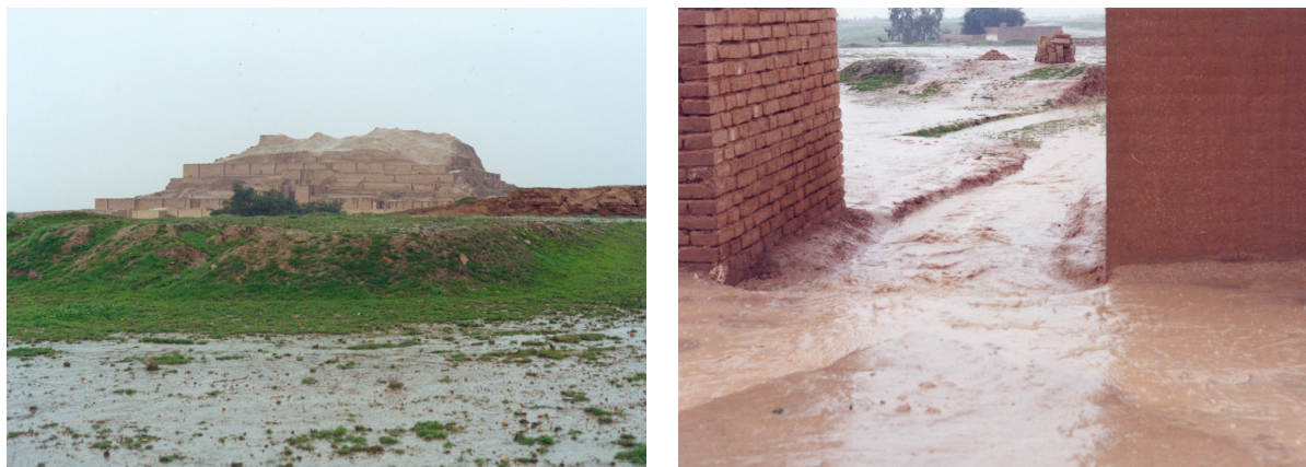
Fig. 104 : stagnation et ruissellement d'eau lors d'un épisode pluvieux à Tchoga Zanbil. (©CRAterre, D. Gandreau, 2002)
