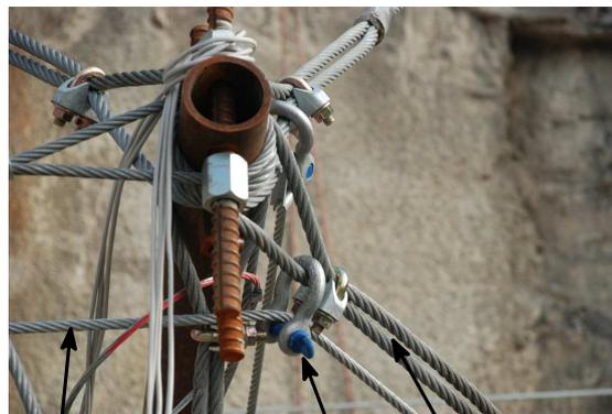
FIGURE 5.16 – Détail d'assemblage de la tête de poteau de l'écran C2ROP
