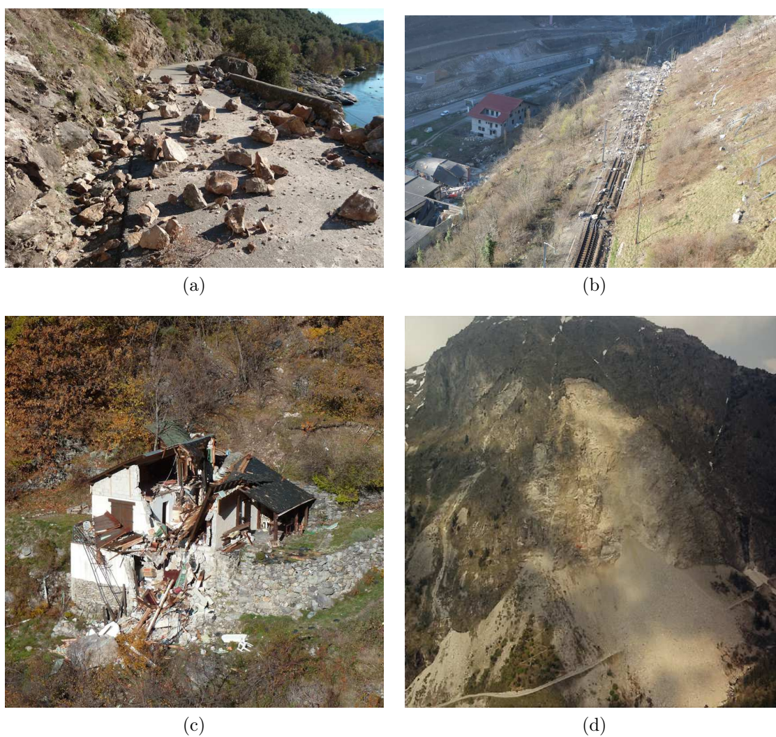
FIGURE 1.1 – Dégâts causés par différents types d'éboulements rocheux : (a) chute de pierres sur une route à Pont-de-Labeaume (07) ; (b) éboulement sur la voie de chemin de fer et la zone d'activité à La Saulcette (73) ; (c) chute de bloc sur un chalet à Belvédère (06) ; (d) éboulement majeur à Vaujany (38) (source Cerema)
