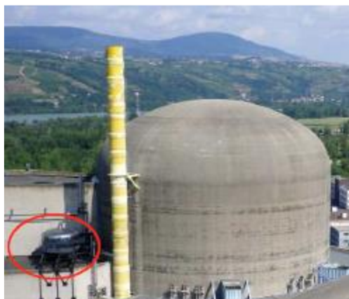
Figure 6 : Photo du bâtiment réacteur (Centrale Nucléaire à Saint-Alban, France). Le cercle rouge montre le filtre à sable utilisé.
