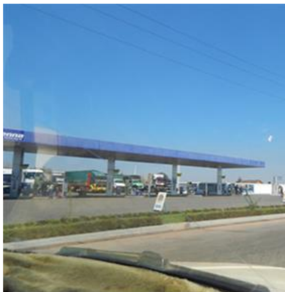
Photos 9 : Station-service Jovenna construite en face
