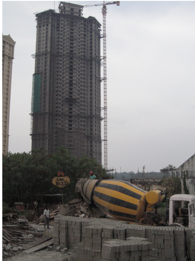
Photographie 1.1 – La tour Bay View en construction dans le projet Hiranandani Upscale à Egattur
