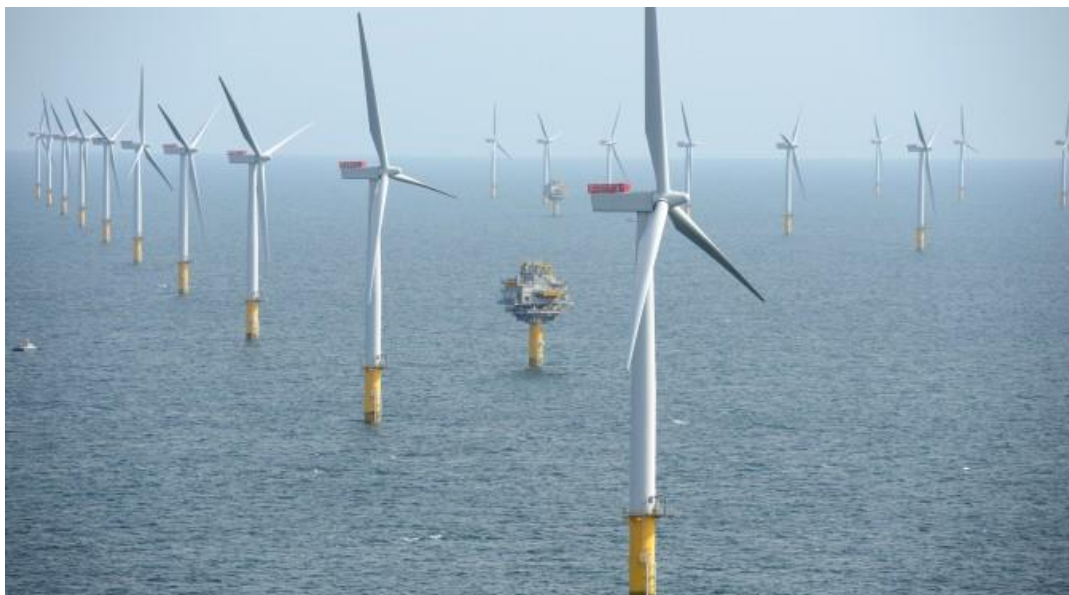
Figure 1.2: Parc d'éoliennes en mer ( http://transition.web.unc.edu/ )
