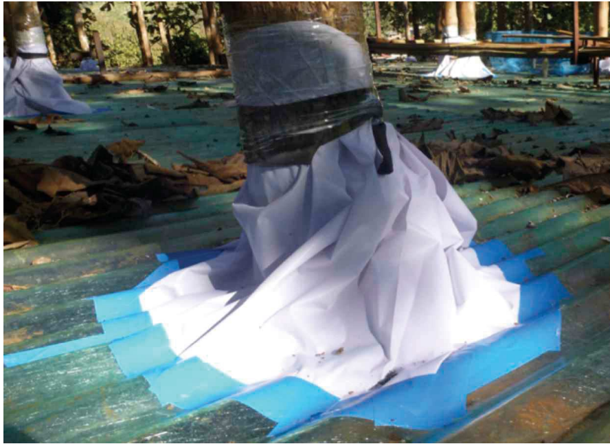
Photo 15: Jupe évitant l'écoulement de l'eau de pluie le long des troncs.
