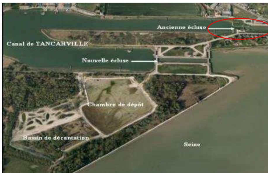
Figure I-1. Chambre de dépôt de Tancarville, écluses, zone de décantation et lieu de prélèvement des sédiments pour les études (entouré en rouge).
