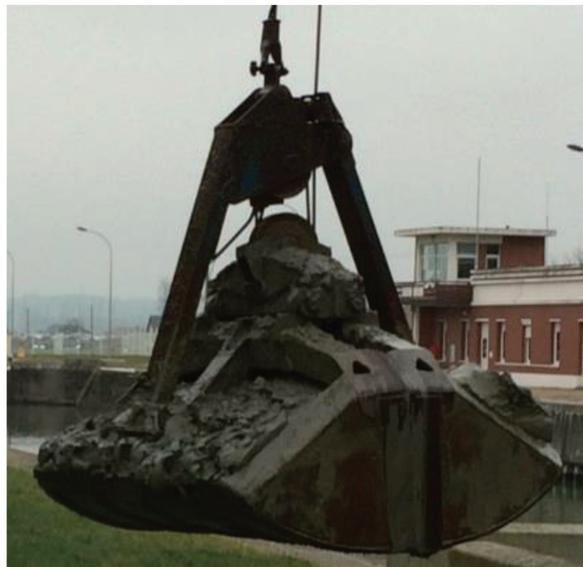
Figure II-1. Prélèvement des sédiments dragués au fond de l'ancienne écluse de Tancarville.
