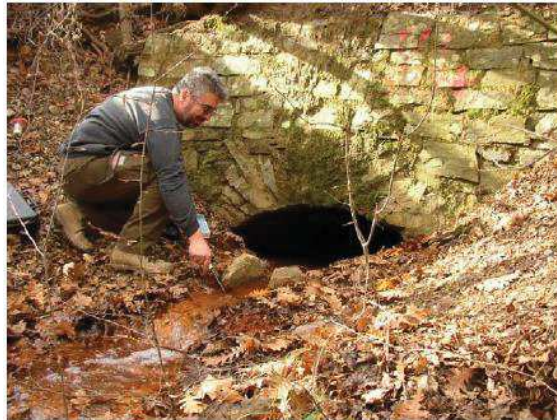
Figure 3-2 : Émergence d'eaux minières à la sortie d'une ancienne galerie (Artignan, 2008)
