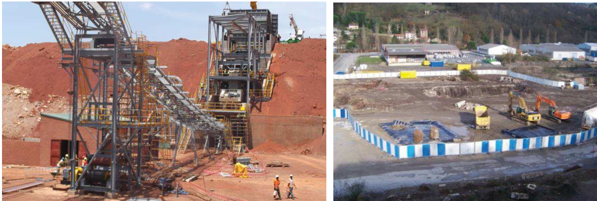
Figure 1-2 : Construction d'une mine au Burkina Faso (ORTEC, 2017)
