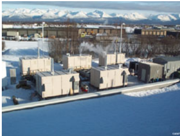
Figure 1.10 : Cinq systèmes de piles à combustible UTC (PureCell™ 200, 200 kW) en Alaska, USA [Utc].
