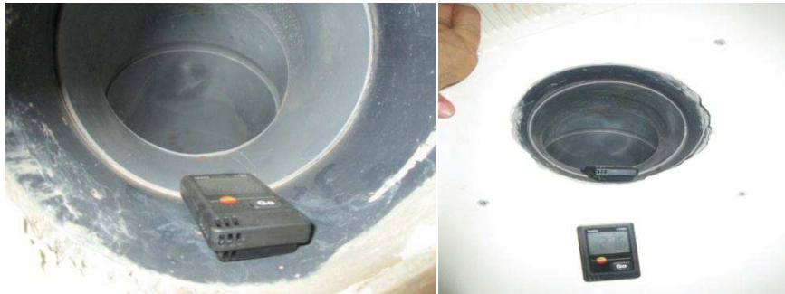
Figure.III.9.b : Mise en place du TESTO174H dans la bouche du soufflage dans le grand salon de la maison AMYS.
