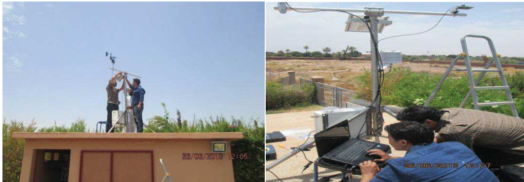
Figure.III.11.Installation et configuration de la station météo BWS200 sur le site AMYS.
