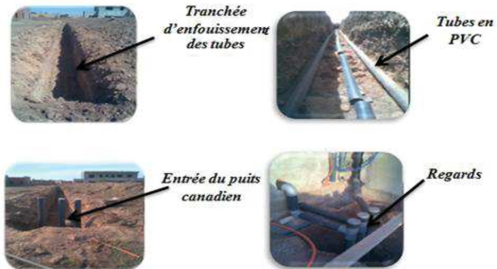
Figure. III.2. Schéma du puits installé dans la maison AMYS, photos de sa mise en place.
