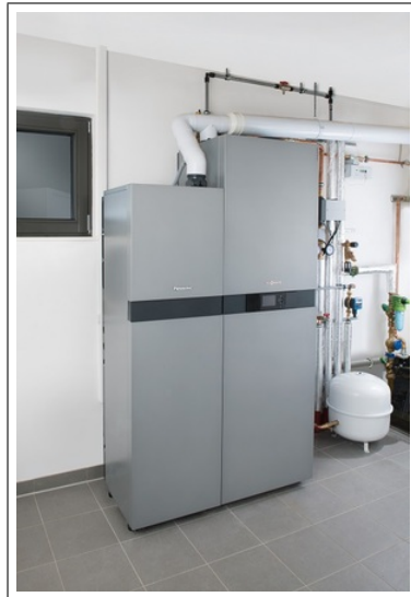
FIG. 1.11 – Pile à combustible Vitovvalor 300-P de 20 kW thermique et 750 W électrique développée par Viessman. Elle est en cours de test à Forbach (57) en France. [25].
