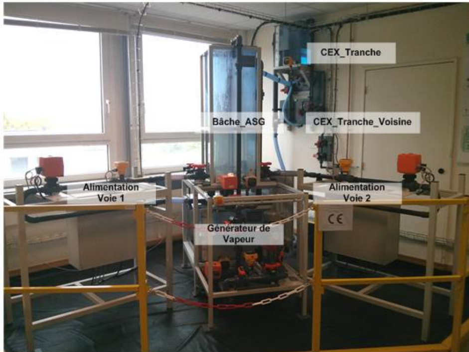
Figure 19 : Processus physique de la plate-forme CISPI à conduire (hydraulique) – Emulation du procédé ASG (Alimentation Secours des Générateurs de Vapeur)
