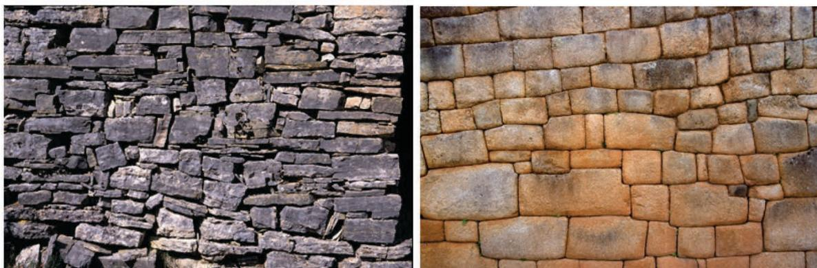
*Figure 1 : A droite : Pierre sèche en plaquettes brutes à Saignon (Vaucluse), France, source Wikipédia, A gauche : Joint vif, Machu Picchu, Pérou, vers 1440, source Wikipédia*
