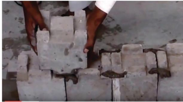
**Figure 9 : Exemple de construction avec des blocs imbriqués –Inde, source Wikipédia**
