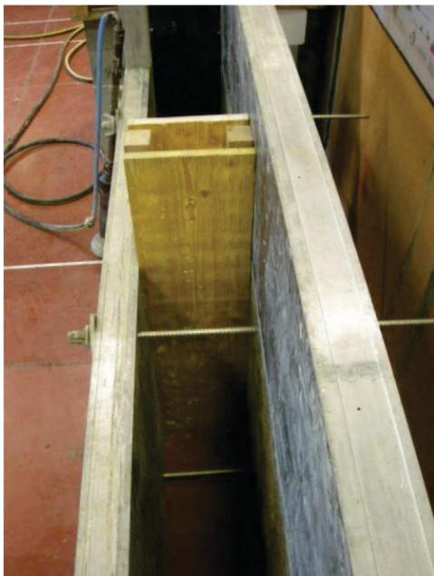
*Figure 151 : Vue sur les tiges filetées de la banche*
