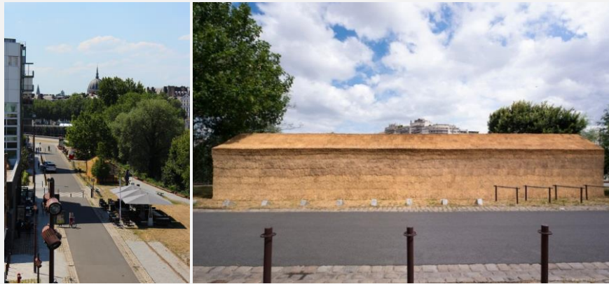
Figure 167 et 168 : Vue de la route, la façade est aveugle.
