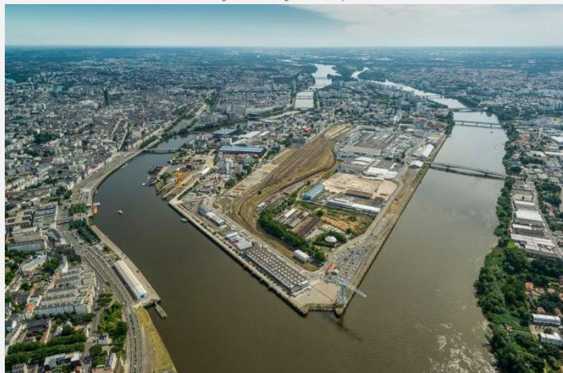
Figure 181 : Île de Nantes, pointe ouest, juillet 2016.
