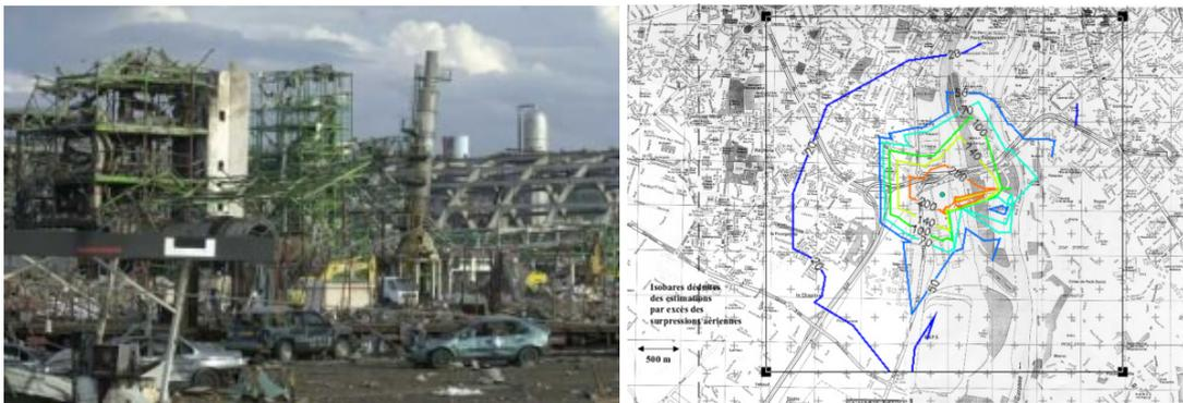
FIGURE 1.3 – À gauche, photographie du site industriel de l'usine AZF après l'explosion du 21 septembre 2001, d'après [82]. À droite, niveaux de surpression, en mbar, estimés par l'INERIS à partir des dommages observés [36].
