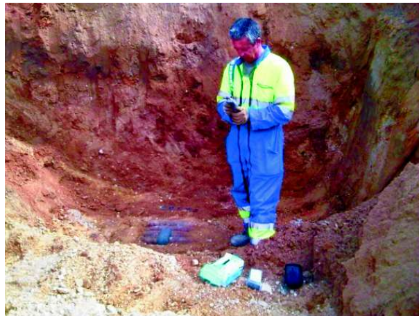
FIGURE 1.16 – Mise en place d'un explosif de type plastrite (explosive) sur quatre obus d'artillerie de 155 mm, sur un chantier militaire.
