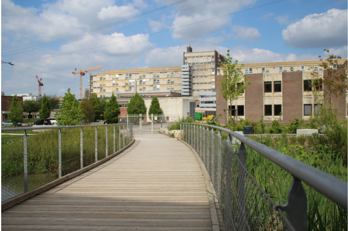
Figure 25 : Barrière entre l'hôpital et le pont qui mène aux immeubles, vue sur l'hôpital
