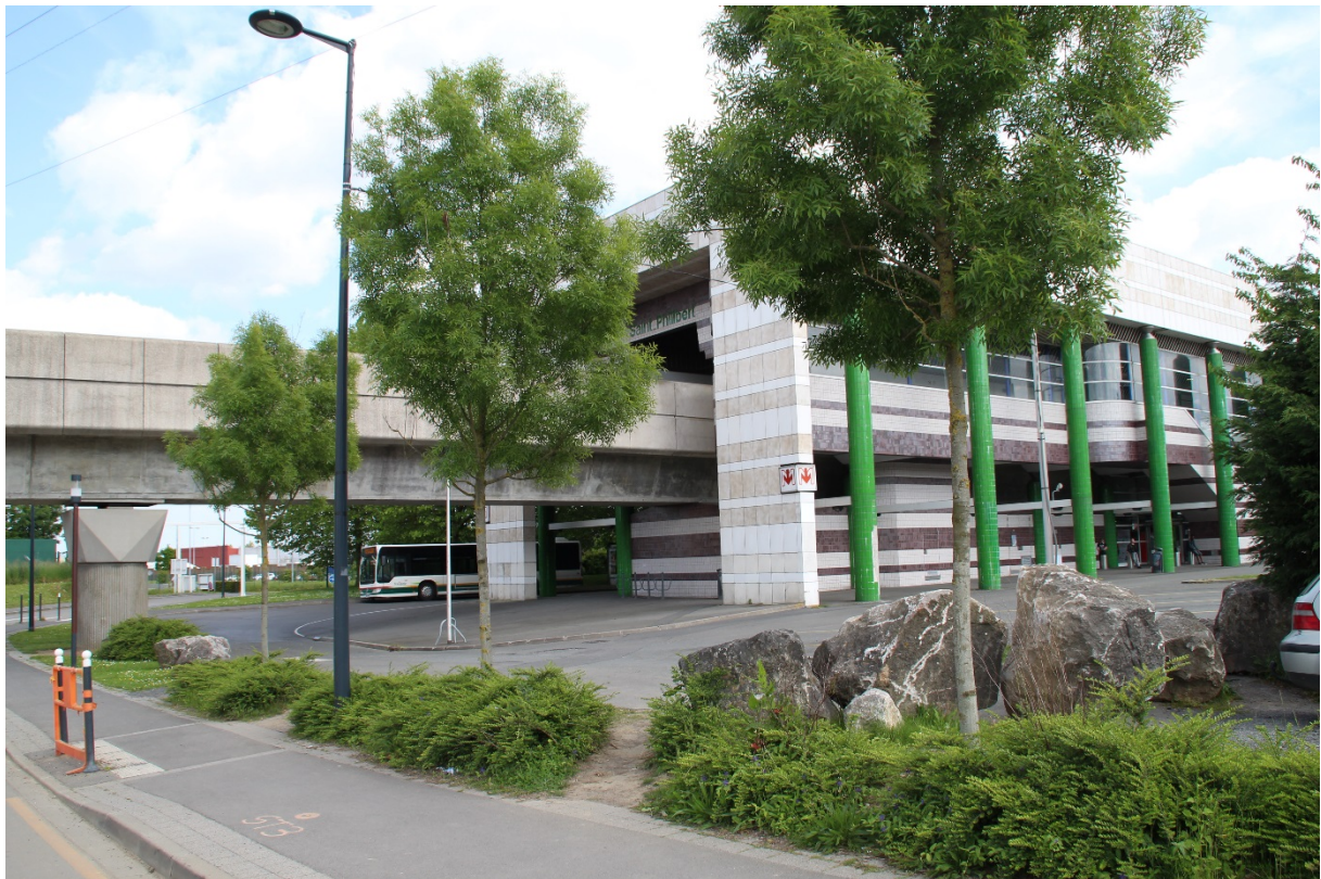
Figure 23 : Enrochement, trottoir inaccessible en fauteuil roulant et chemin de désir 84
