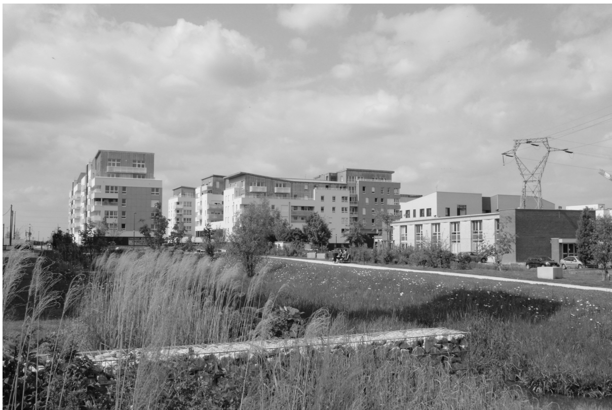
Figure 5 : Vue du pont, prise le 24/05/2015
