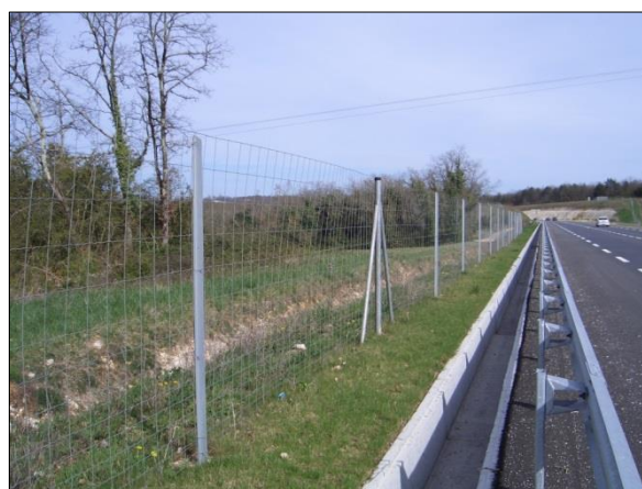
Clôture « grande faune » à gauche. Entre la route et la clôture : un crapauduc
