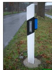
Réflecteur (en bleu) sur balisage de délimitation de chaussée
