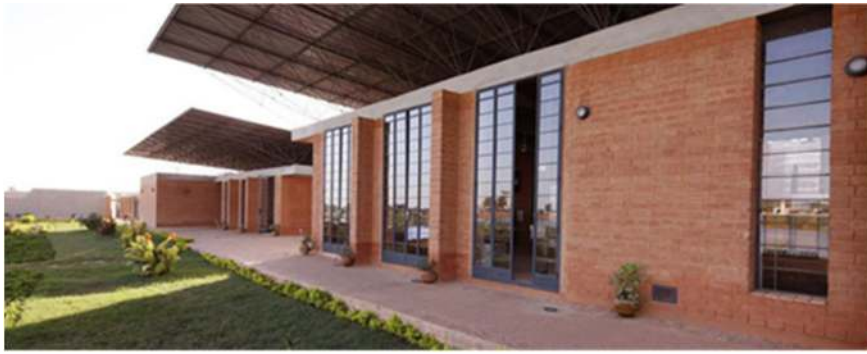
Figure I. 2 : Centre de l'architecture de terre au Mali
